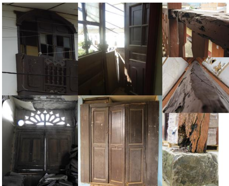
Consolidación de la Carpintería de madera
