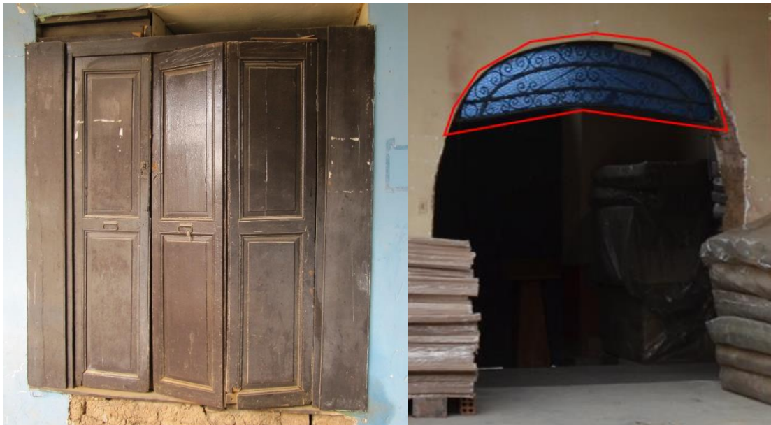
Liberación de carpintería y elementos arquitectónicos que no pertenecen al bien inmueble.
