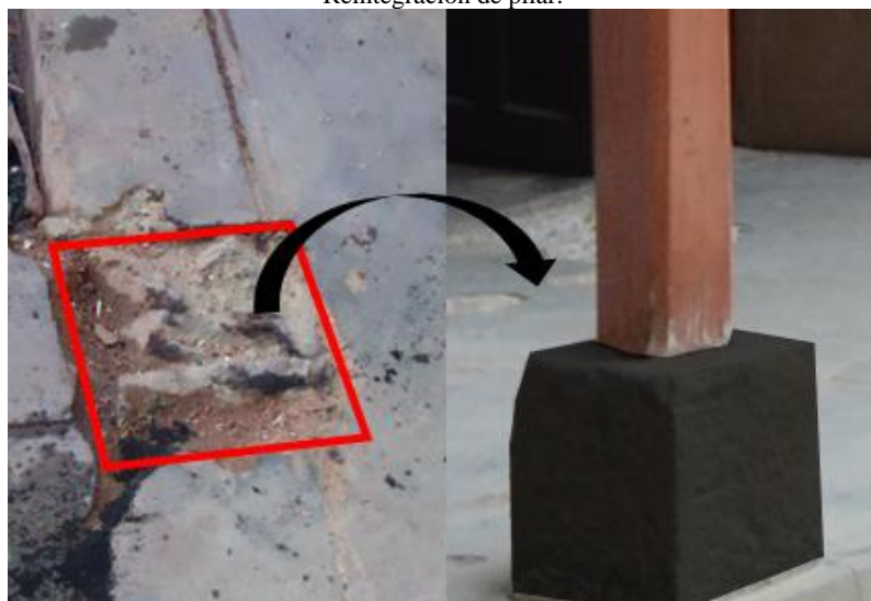
Reconstrucción de base de pilar.
