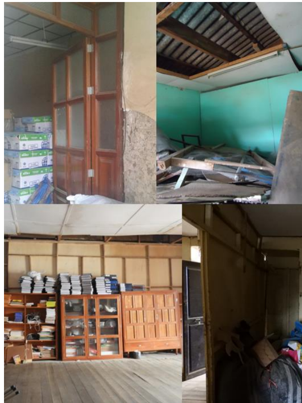
Liberación de Tabiquería en la Escuela de Primeras Letras
