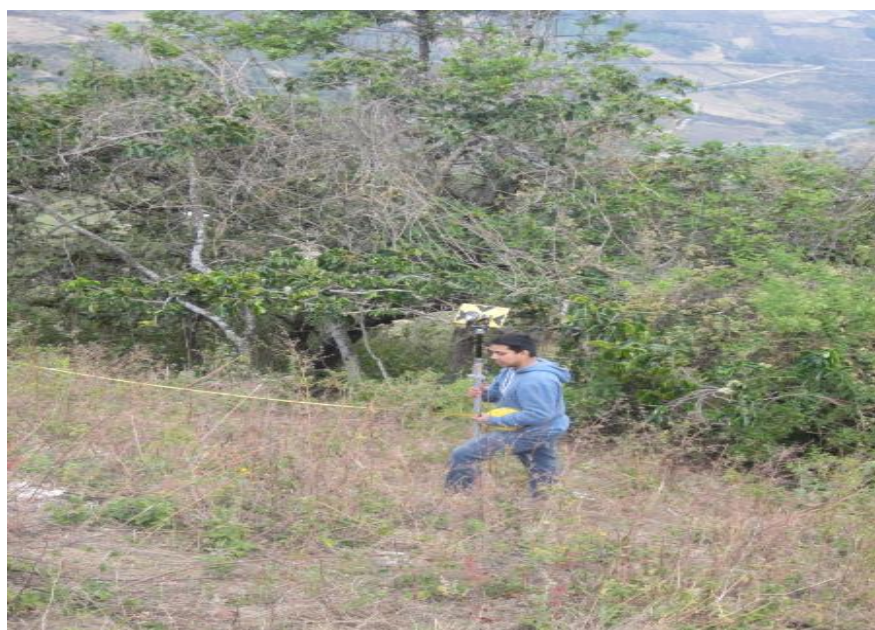
Figura N° 06: Levantamiento Topográfico con Estación Total
