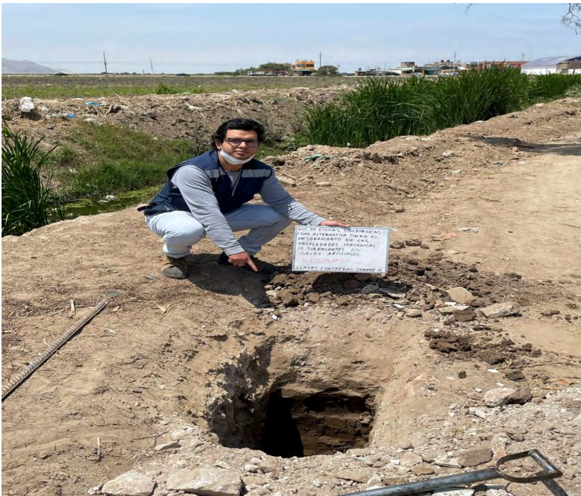
Extracción de muestra de suelo arcilloso de la Calicata C-2
