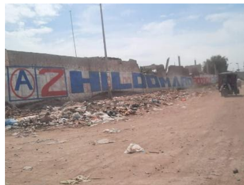
Figure 17: Muro ciego en Av. Prol. Mexico.
