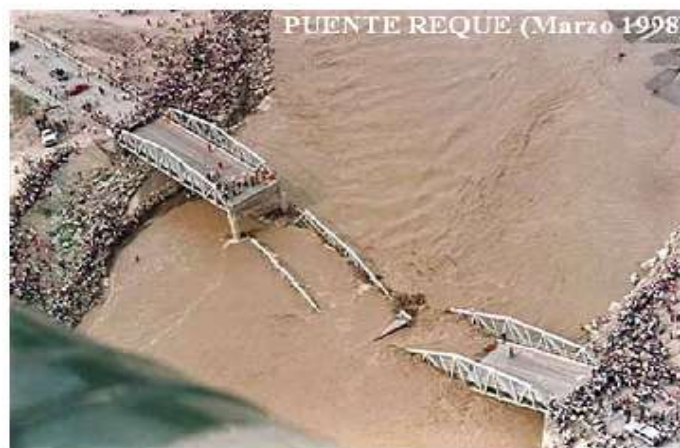
Figura N° 12: Puente Reque (marzo 1998)
