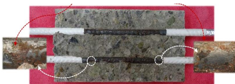
Fig. 2 Inspección de corrosión del acero embebido en concreto [18]
