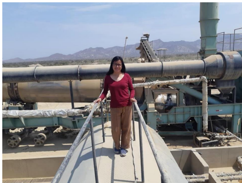
Figura 38: Visita planta de asfalto.
