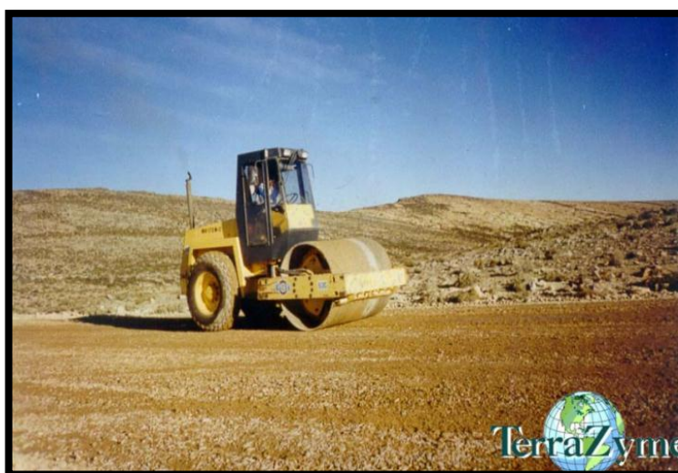
FOTOGRAFÍA N° 7.8: Paso 4 Compactación del suelo
