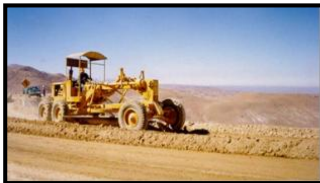
FOTOGRAFÍA N° 7.4: Paso 1 Escarificación del Suelo
