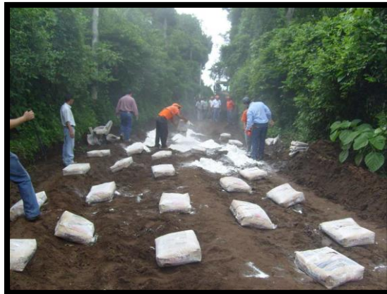
FOTOGRAFÍA N° 7.12: Apertura de las bolsas de cal
