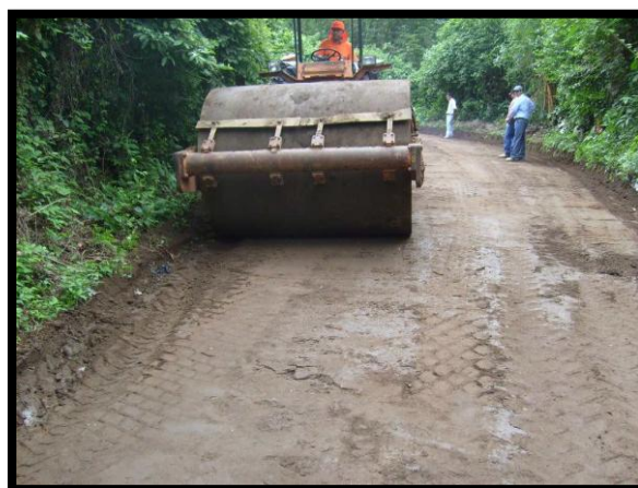
FOTOGRAFÍA N° 7.16: Compactación del suelo
