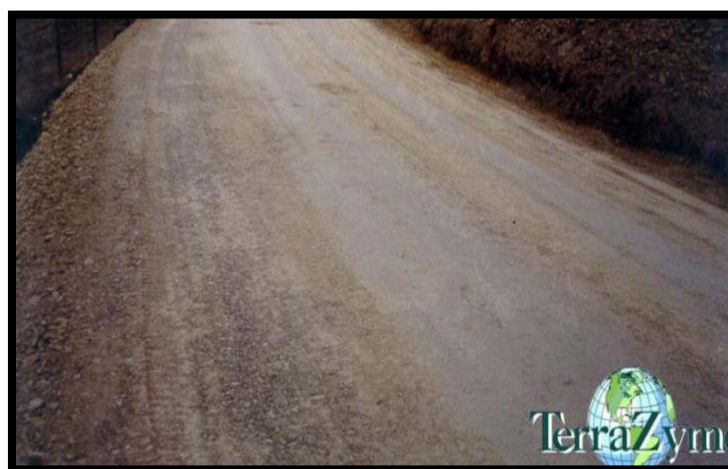
FOTOGRAFÍA N° 7.9: Paso 5 Listo para el tránsito vehicular
