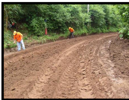
FOTOGRAFÍA N° 7.10: Preparación del suelo
