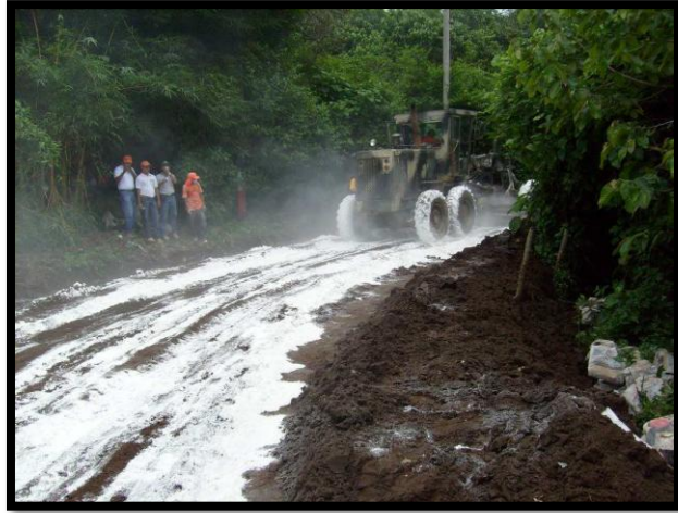
FOTOGRAFÍA N° 7.14: Mezclado del suelo y cal
