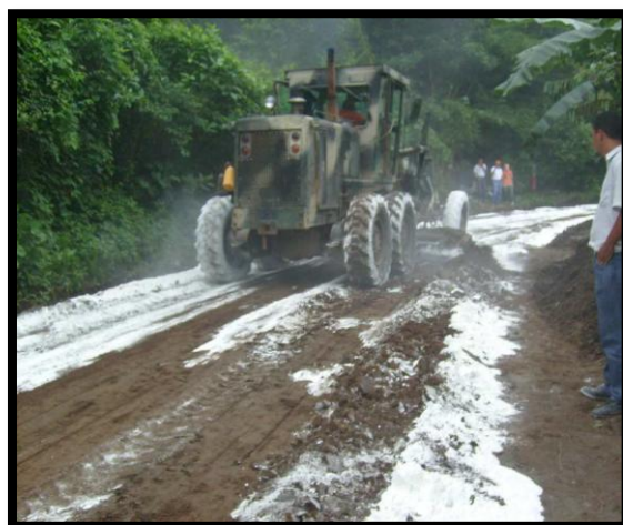
FOTOGRAFÍA N° 7.15: Motoniveladora para mezclar el suelo y cal
