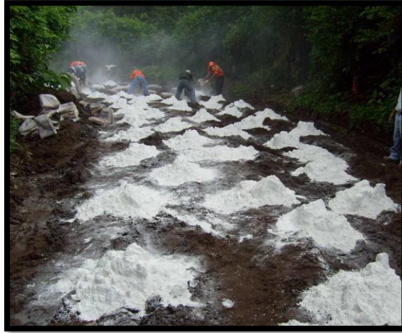
FOTOGRAFÍA N° 7.13: Extendido de cal
