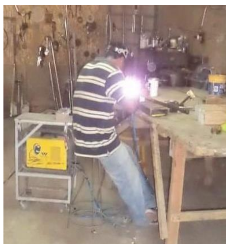
Figura 8. Soldado y armado de trampa de sólidos y grasas
