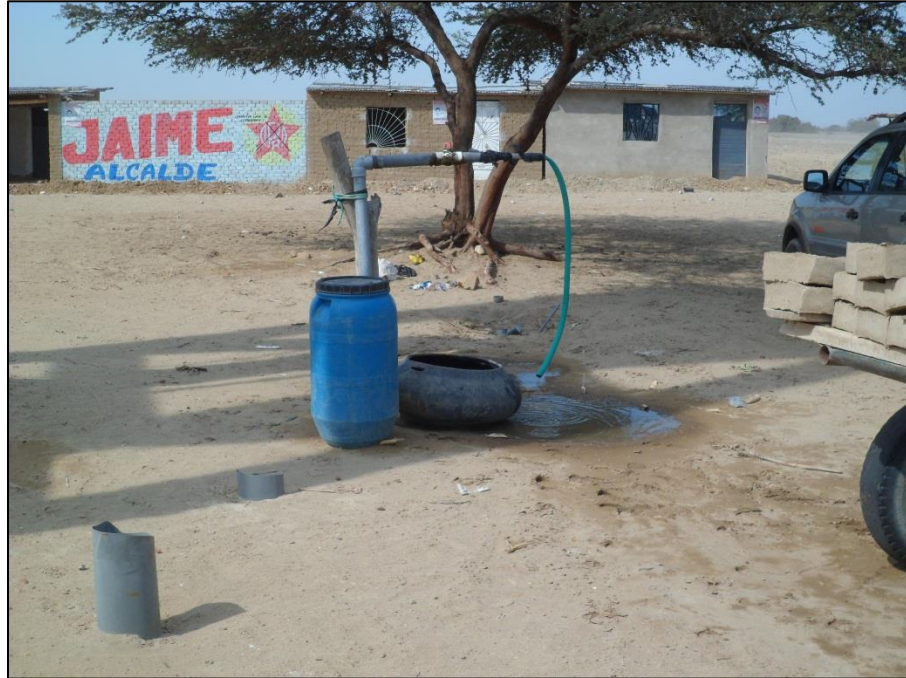
Figura 6. Cañería conectada al pozo por donde se abastecen de agua Fuente: Fotografía propia
