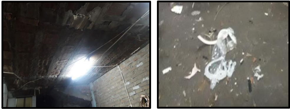
Figura 265. Techo, paredes y suelo
