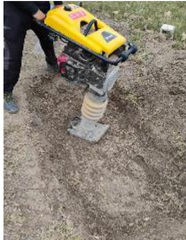
Compactación y mezcla en el tramo de prueba con aditivo
