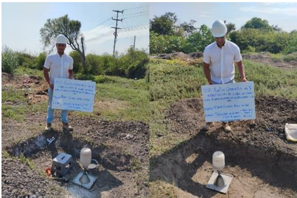
Fig. 29 Ensayo Cono de arena 1
