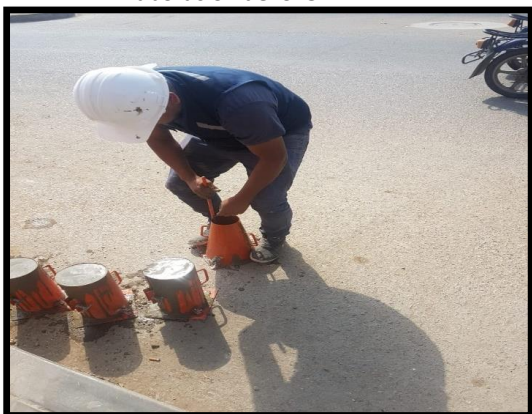
Elaboracion del SLUMP
