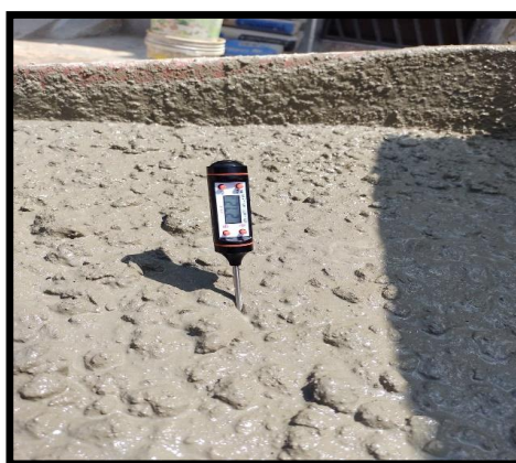
Temperatura del concreto
