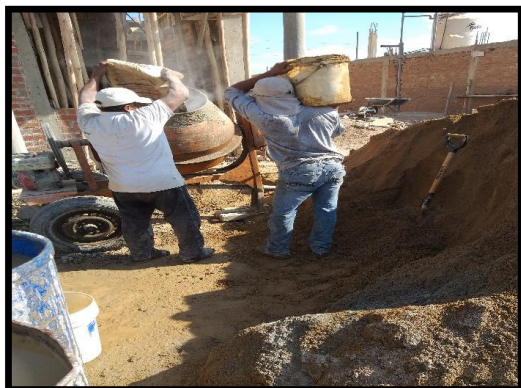
Mezclado del Concreto
