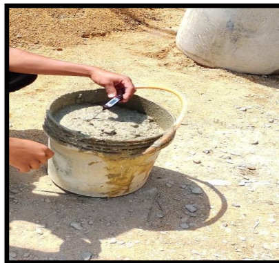
Temperatura del concreto
