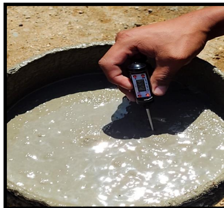
Temperatura del concreto
