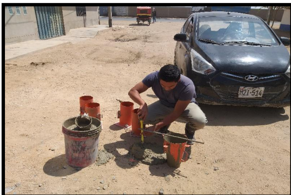
Elaboracion del SLUMP
