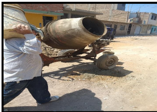
Elaboracion del Concreto
