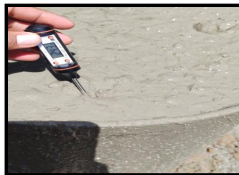
Temperatura del concreto
