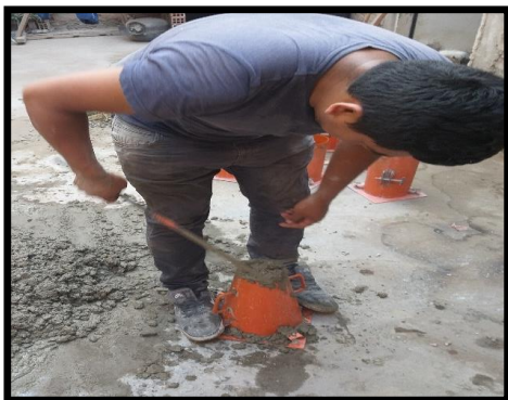
Elaboracion del SLUMP
