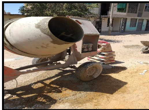
Mezclado de concreto
