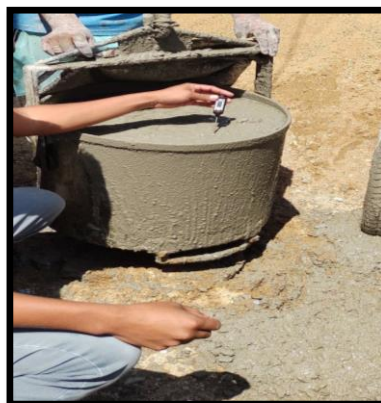
Temperatura del concreto
