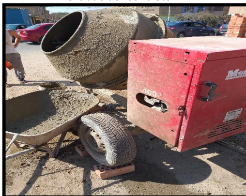
Mezclado del Concreto
