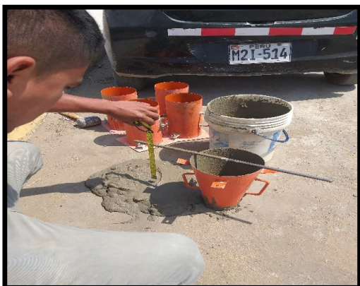
Elaboracion del SLUMP
