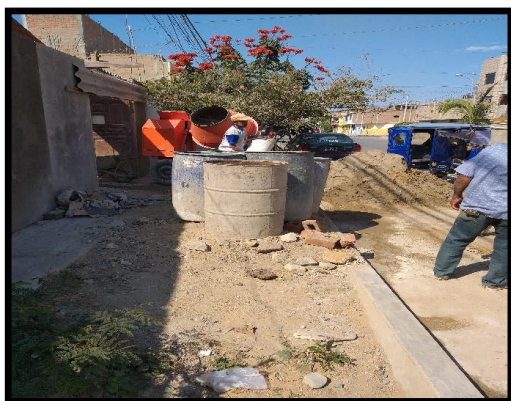
Mezclado del Concreto
