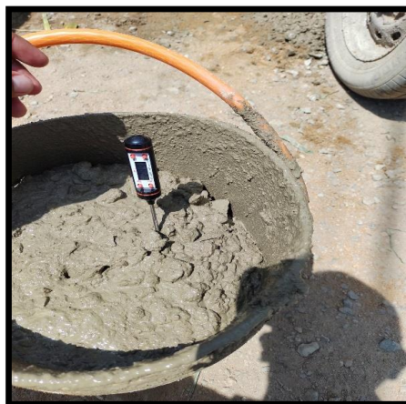
Temperatura del concreto
