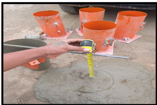
Elaboracion del SLUMP
