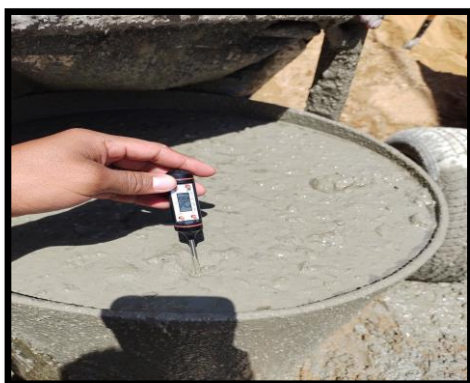
Temperatura del concreto
