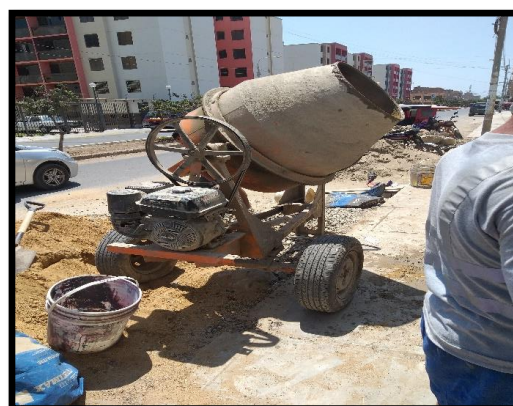
Mezclado de concreto
