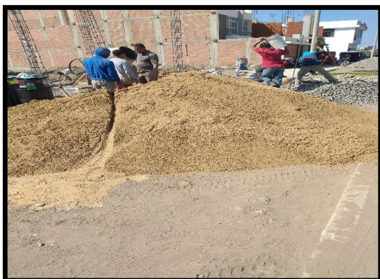
Elaboracion de la mezcla
