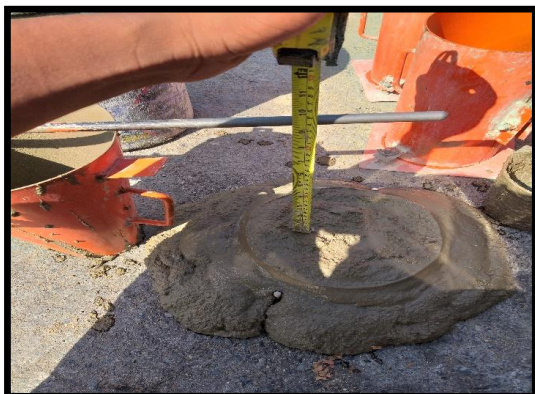
Elaboracion del SLUMP
