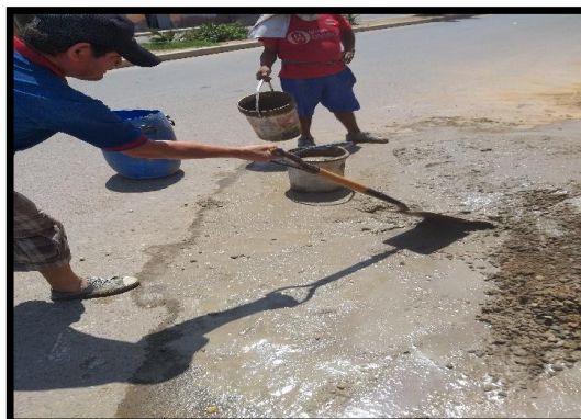
Mezclado de concreto
