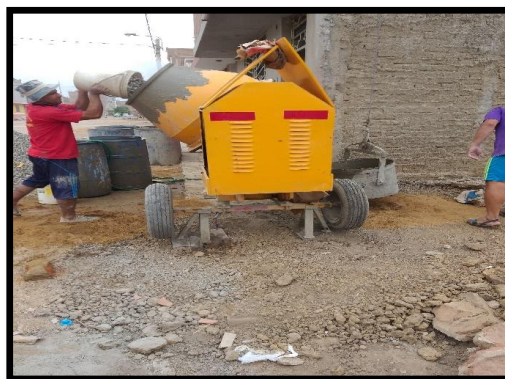
Mezclado de concreto
