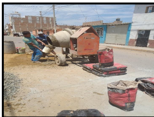
Elaboracion del Concreto
