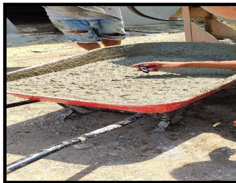
Temperatura del concreto
