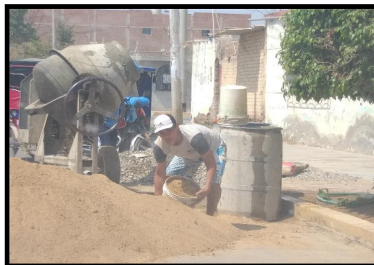
Elaboracion del Concreto
