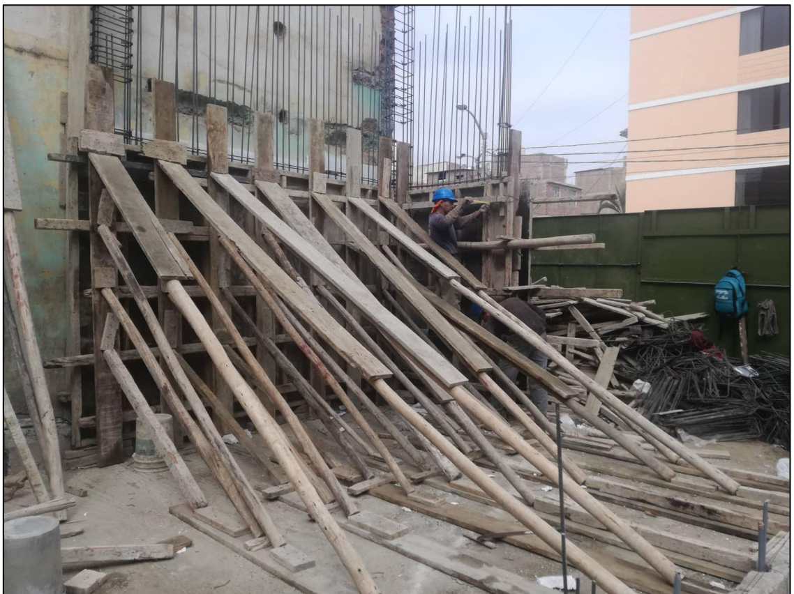
Anexo 07: Encofrado de Placas
