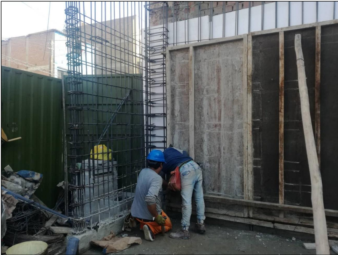
Anexo 07: Encofrado de Placas
