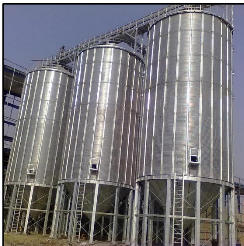
Figura N°35: Silos de almacenamiento de materia prima
