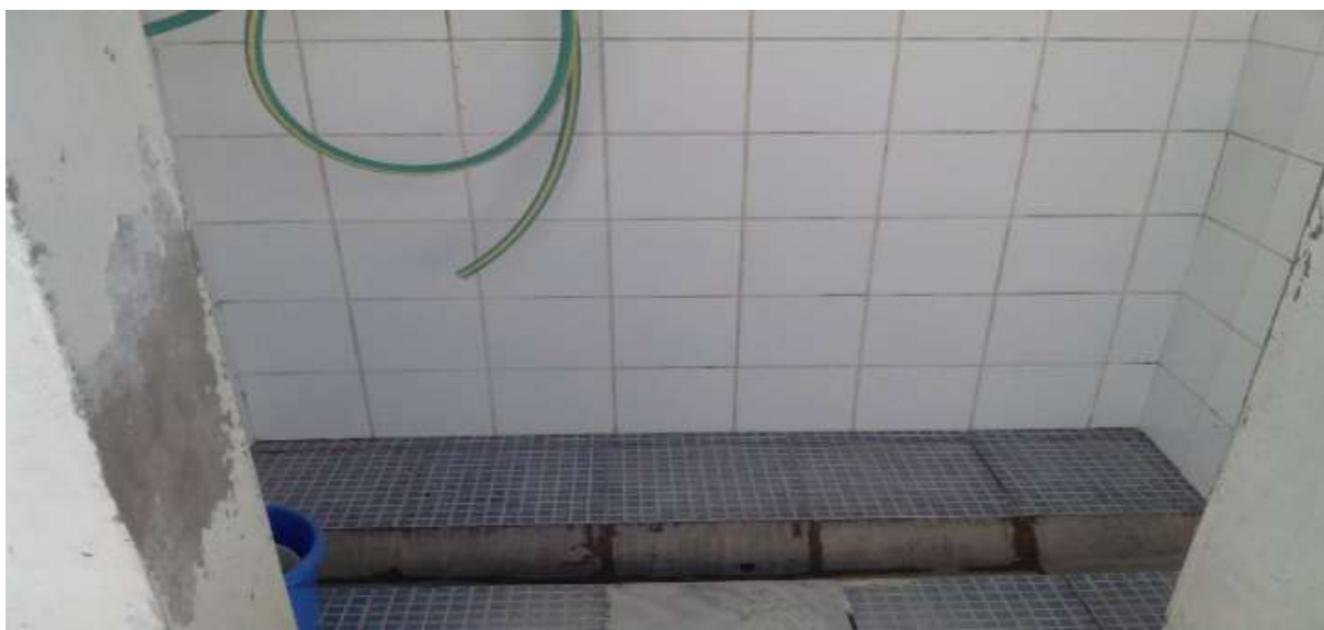
Figura N° 12. Área de Pre Lavado I Fuente: Industrias y Derivados S. A. C.
