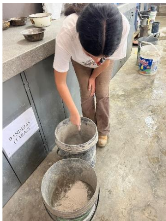
Fig. 30. Mezclado de Sika-1 en polvo y cemento
