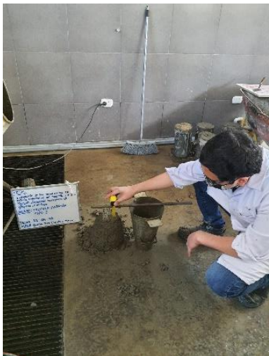
Ilustración 20: Preparación del concreto y verificando del slump de diseño
