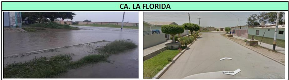
Figura N° IV.29: Inundaciones en Calle la Florida
