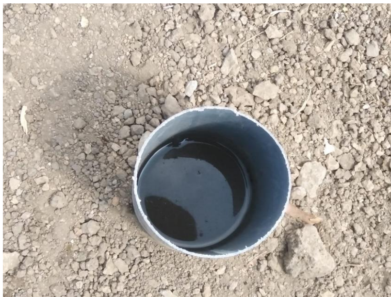
Figura N° IV.6: Prueba de Infiltración Calle La Primavera
