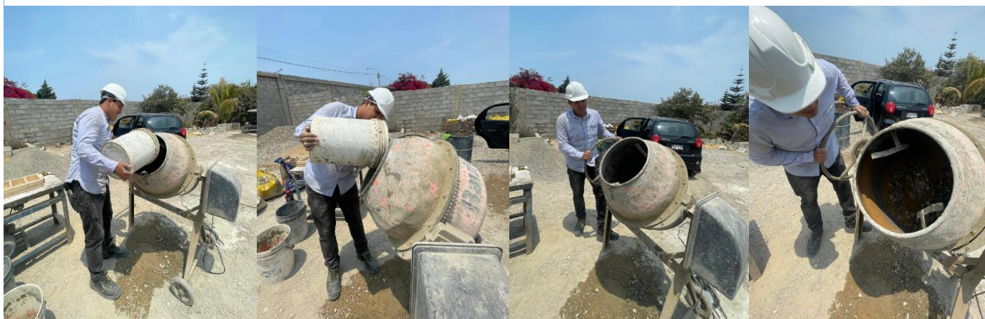
Imagen 62: Vertido de los materiales al trompo giratorio
