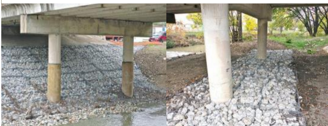
Fig. 76 Protección local de un puente continuo.
