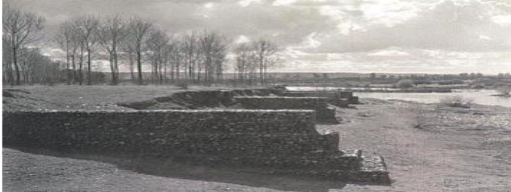
Fig. 74 Espolones transversales en el cauce.
