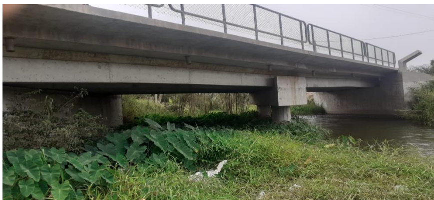
Fig. 10 Puente viga T
