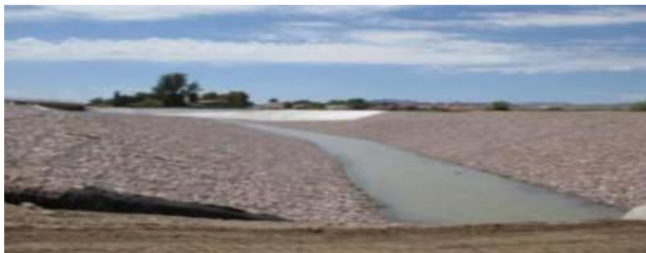
Fig. 73 Protección de talud en canales.
