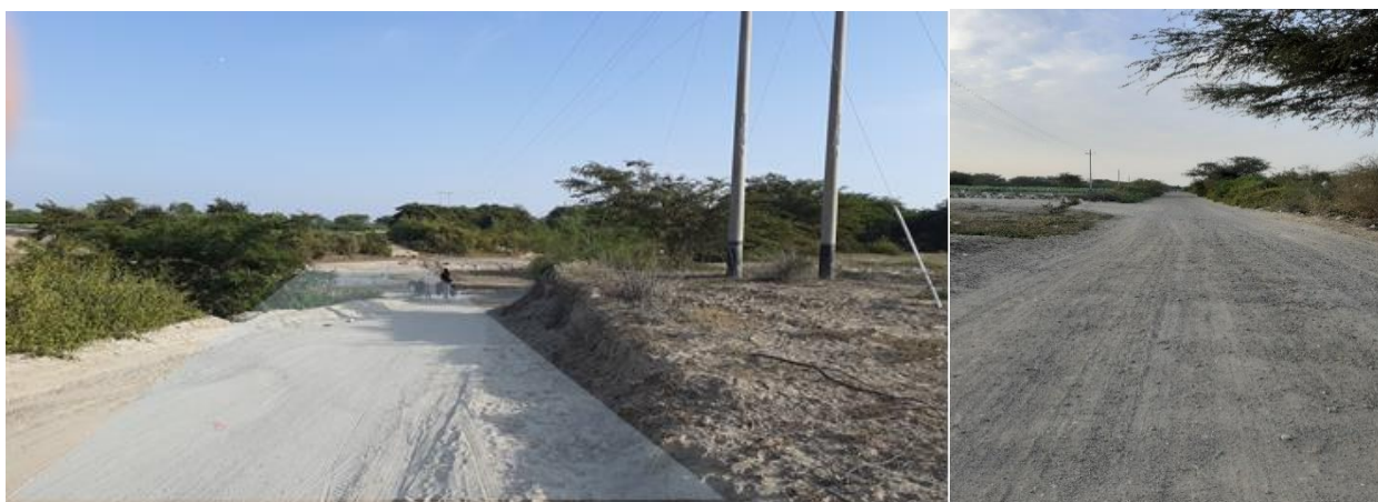
Fotografía N°10.03: Lugar de ejecución del proyecto-carretera existente.
