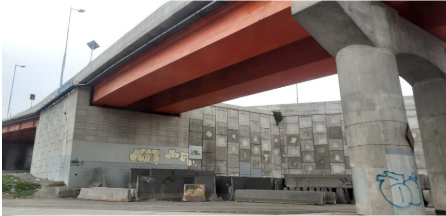
Fuente: Propio – Puente vehicular urbano en Lima
