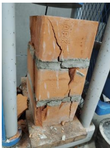
Imagen 65: Falla en la parte frontal de la pila P3 - MP 1:3
