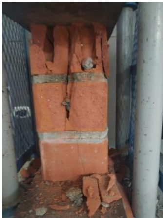
Imagen 77: Falla en la parte frontal de la pila P9- MM 1:3 (10%CLA)
