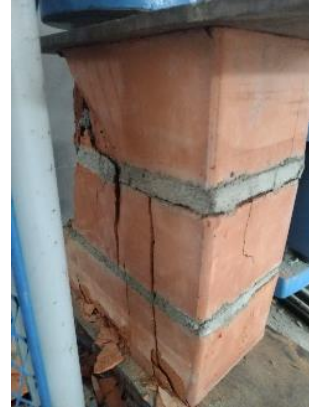
Imagen 83: Falla en la parte lateral la pila P12- MM 1:3 (15%CLA)
