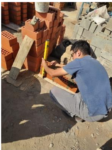
Imagen 54: Construcción de muretes
