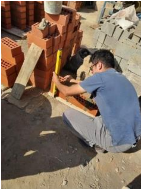
Anexo 51.1. Construcción del murete
