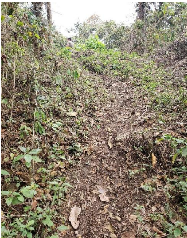
Fotografía N°3.12: Camino de herradura peligroso y gran pendiente
