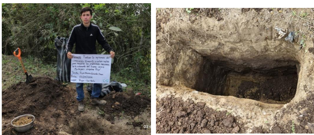
Ilustración 8: Extracción de muestra, calicata C-02
