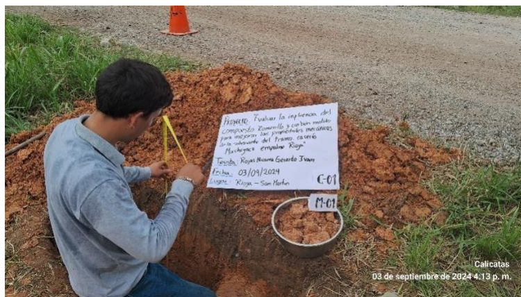
Ilustración 7: Extracción de muestra, calicata C-01
