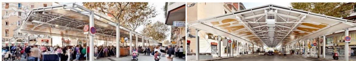
Gráfico 18- Mercado Provisional del Dominical de Sant Antoni, Barcelona. ( Ravetllat Ribas Arquitectos 2011). Fuente: Adrià Goula
