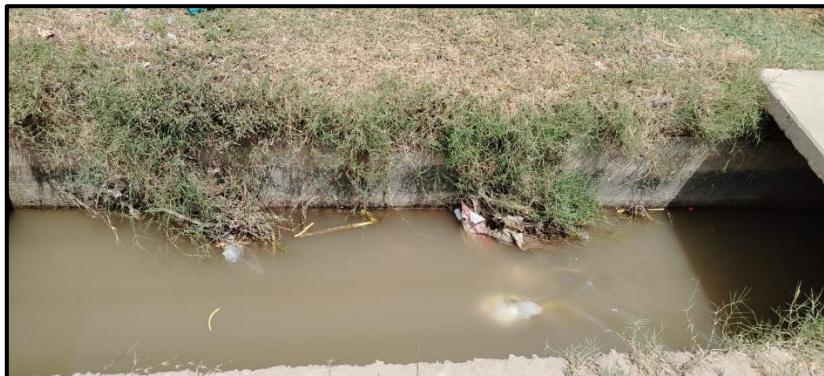
Fig. 91. Presencia de basura que interrumpe el flujo del agua (Calle San Lorenzo Km 4+43.50)
