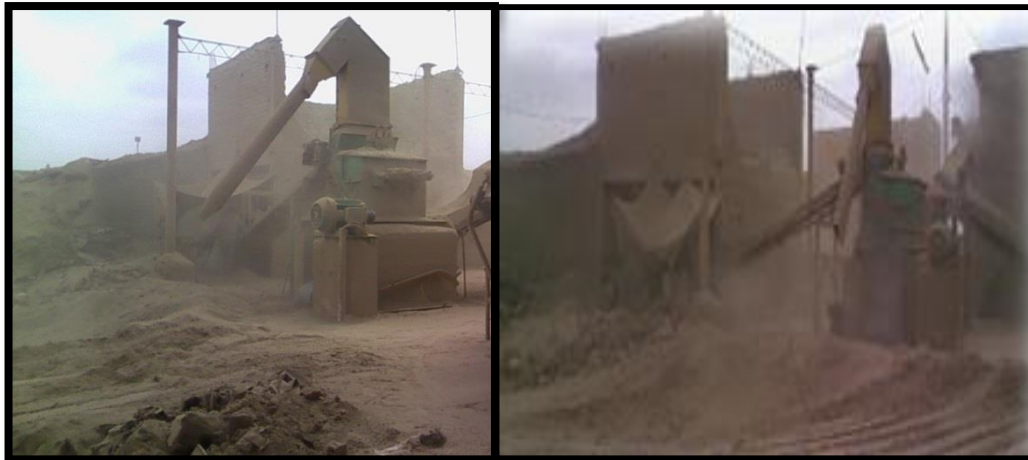
Figura 13: Molienda de materia prima Fuente: Elaboración Propia Fecha: 2014
