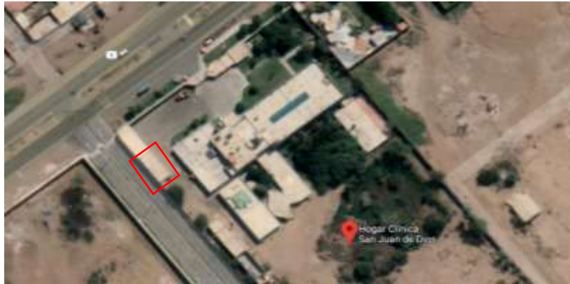
Figura 4. Vista superior del almacén de la Clínica San Juan de Dios Chiclayo
