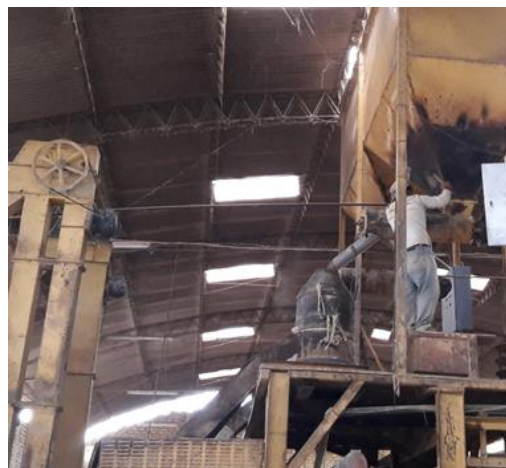
Figura 34. Maquinista ubicado en parte superior maquina peletizadora
