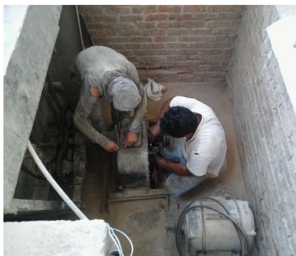
Imagen 03: Falla mecánica en motor de molino 13-01-2017
