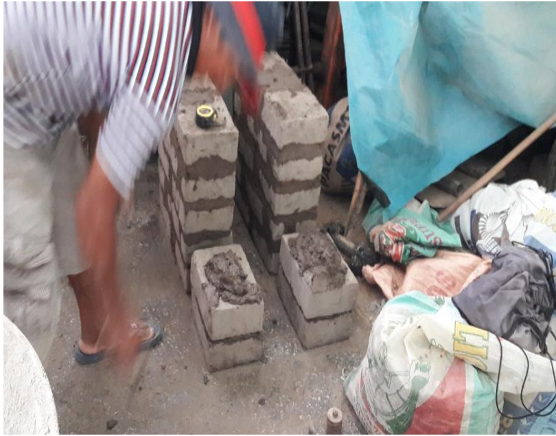
Figura 19. Elaboración de las pilas de adobe
