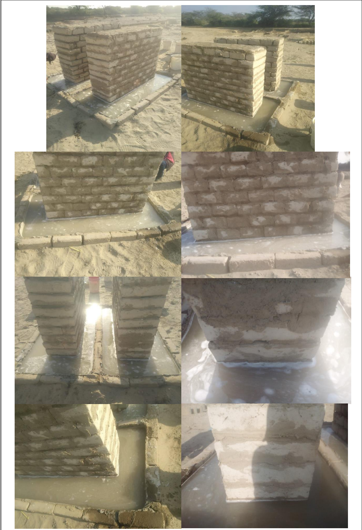
Figura 259.-Muro Mejorado inundado
