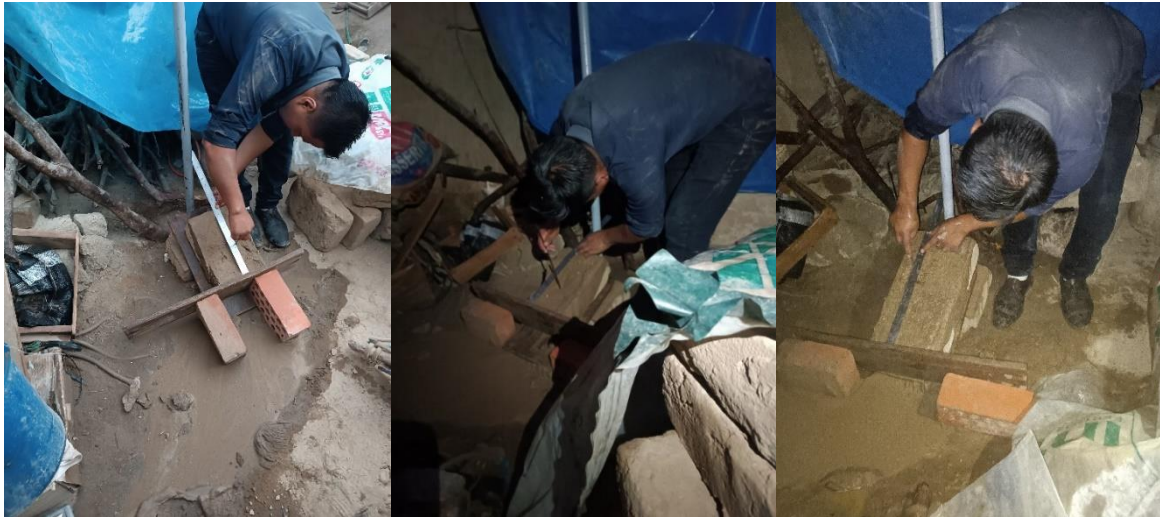
Figura 227.- Medición de la oquedad del adobe
