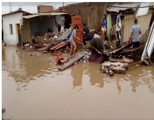
Figura 2.- Vivienda de adobe colapsada
