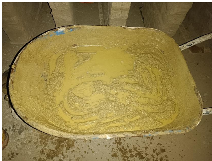
Figura 34.- Preparación del Mortero
