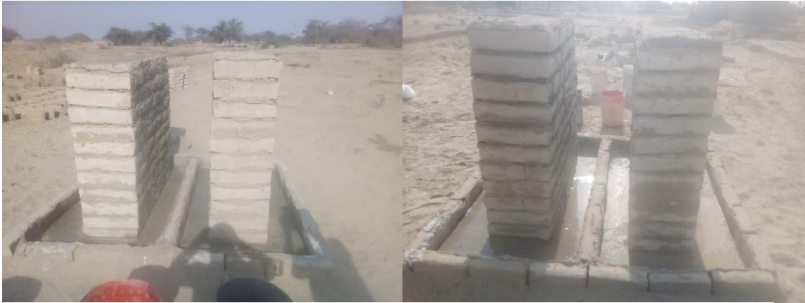
Figura 253.- Impermeabilización del encajonamiento de los muretes
