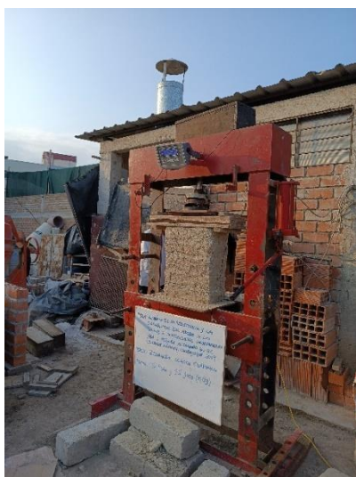
Figura 188.- Vista lateral del murete post ensayo
