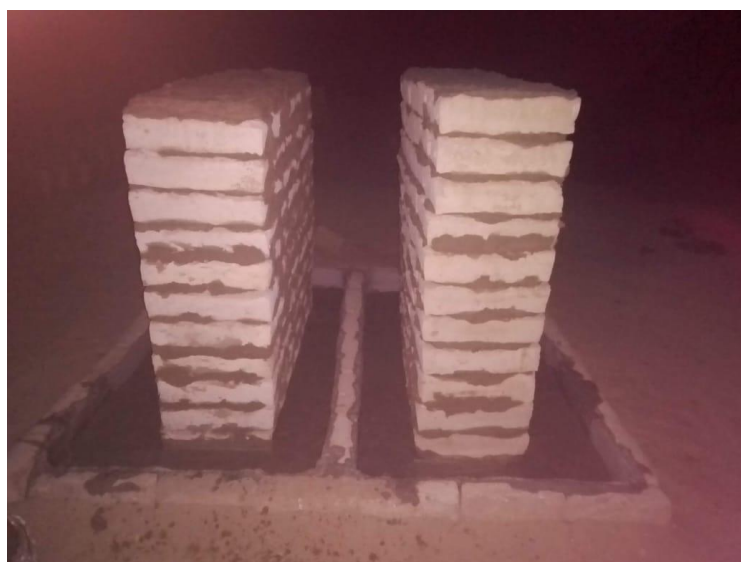
Figura 252.- Construcción de muros para ensayo de Inundación Simulada
