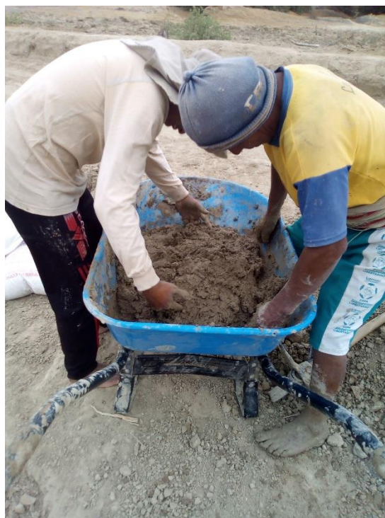
Figura 24.- Homogeneización de la mezcla
