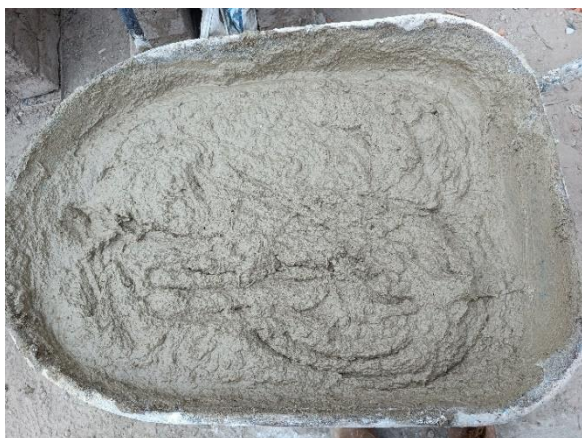
Figura 264.- Preparación del Mortero
