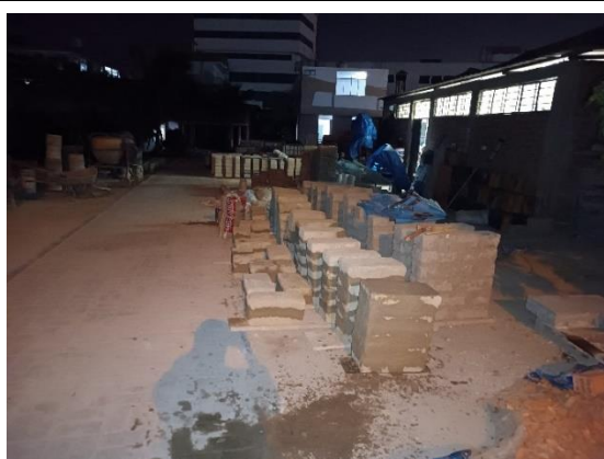
Figura 182.- Construcción de los muretes
