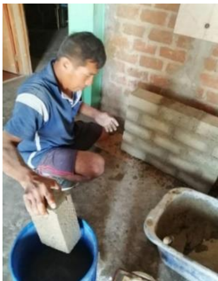
Fig. 27: Elaboración de Murete.
