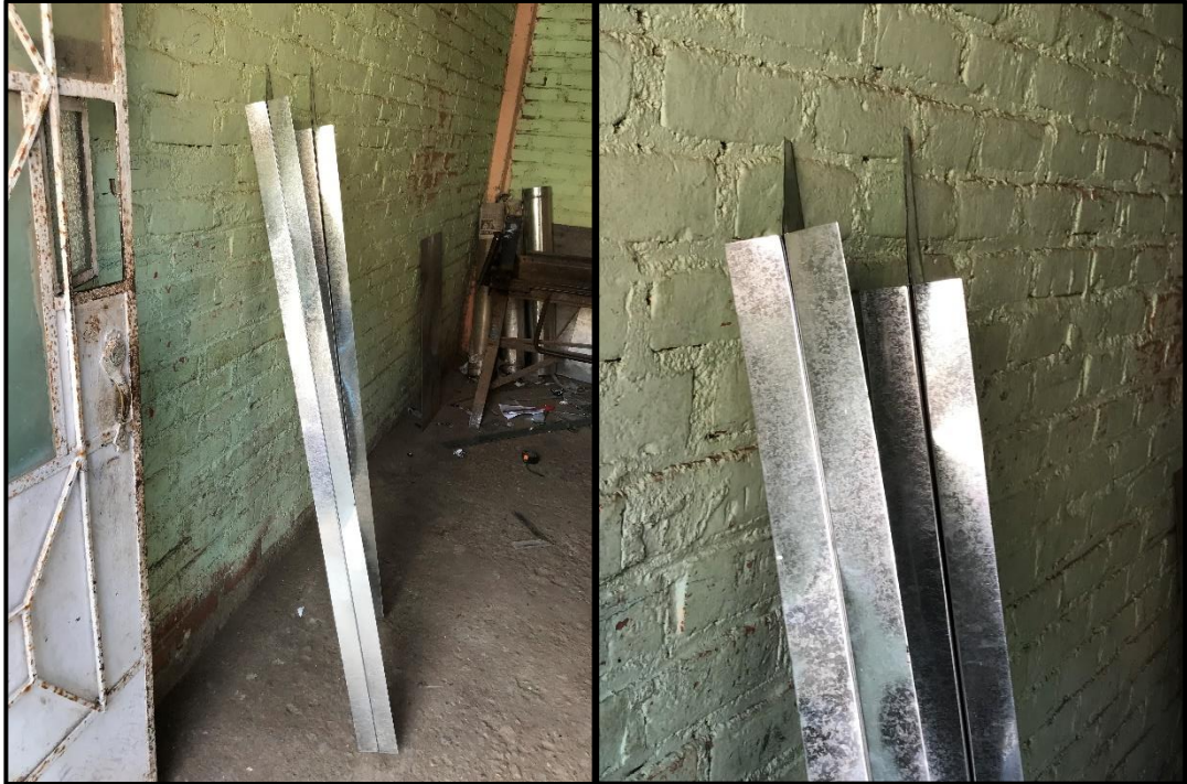
Fotografía N° 21. Fabricación de las Pantallas Deflectoras con planchas galvanizadas – Lagunas de Estabilización a Escala Piloto
