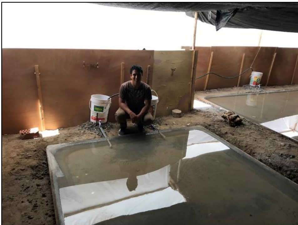
Fotografía N° 20. Estructuras de entrada abastecidas por baldes – laguna anaeróbica a escala piloto
