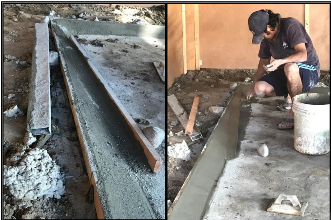
Fotografía N° 16. Construcción de rampas de acceso en modelo a escala
