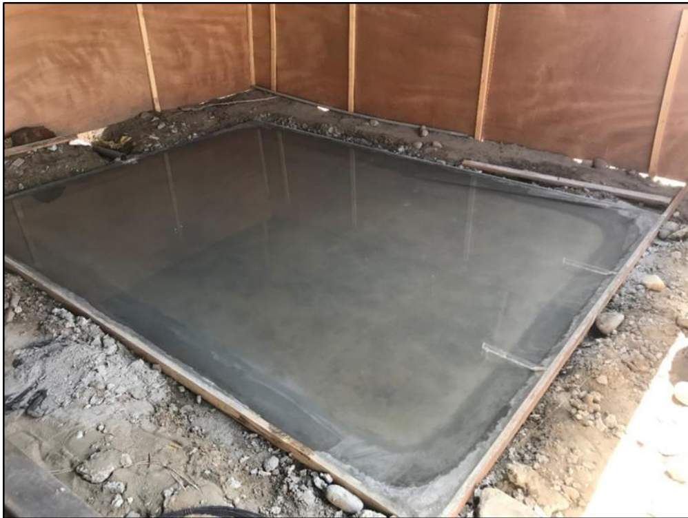
Fotografía N° 19. Prueba hidráulica – laguna anaeróbica a escala piloto
