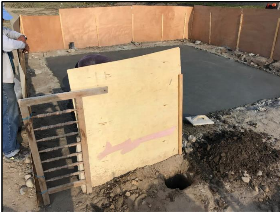
Fotografía N° 14. Excavación puntual de 0.50 m para instalación de postes de eucalipto – techado de modelo a escala piloto
