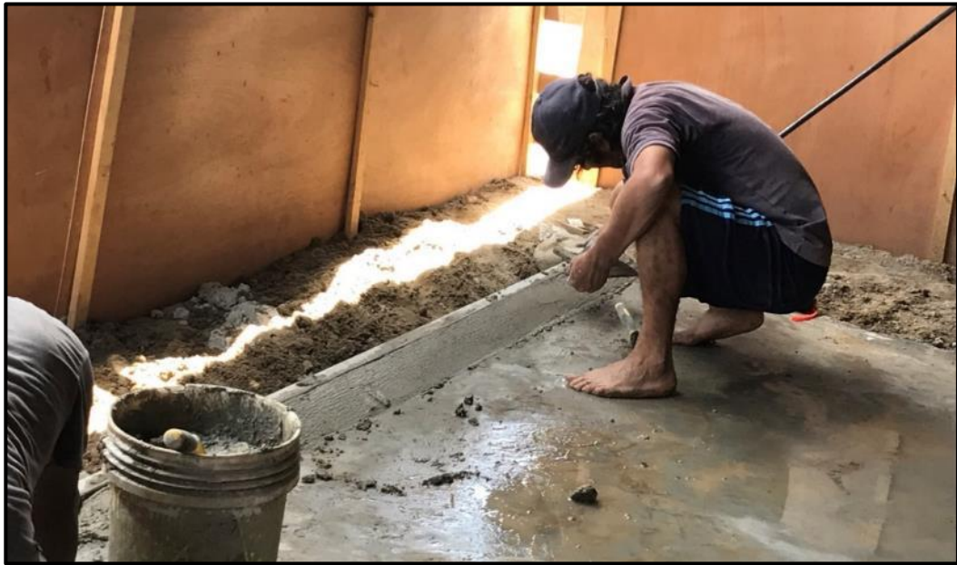
Fotografía N° 15. Construcción de taludes – laguna facultativa a escala piloto
