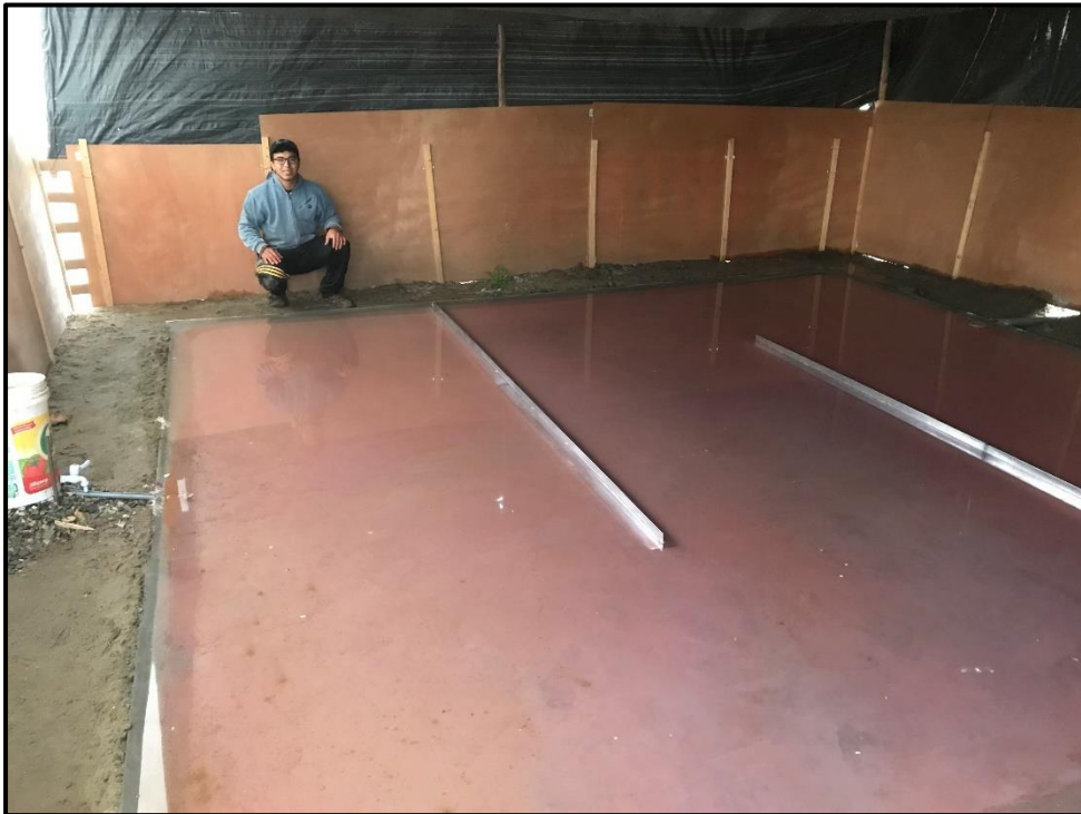
Fotografía N° 23. Disposición de las Pantallas Deflectoras en Lagunas Facultativas a Escala Piloto
