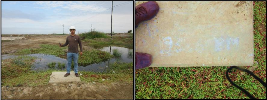
Fotografía N° 1. Toma de datos del BM N° 9326, cerca al cerco perimétrico
