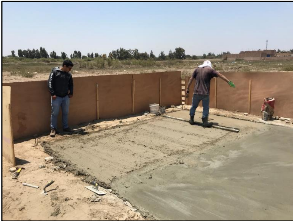
Fotografía N° 13. Construcción de segunda alternativa y definitiva de lagunas de estabilización
