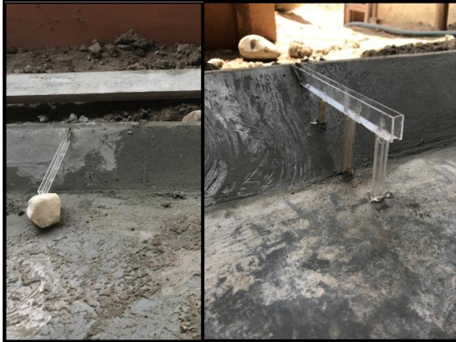
Fotografía N° 17. Instalación de estructuras de entrada – laguna anaeróbica a escala piloto
