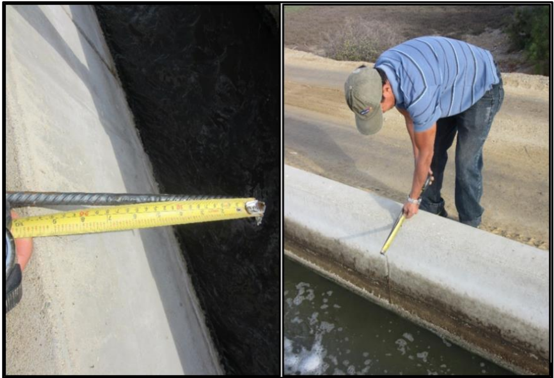
Fotografía N° 9. Determinación del tirante de los canales – Aforo en Entradas de Lagunas de Estabilización
