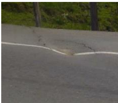
Figura N°06: Hundimiento
