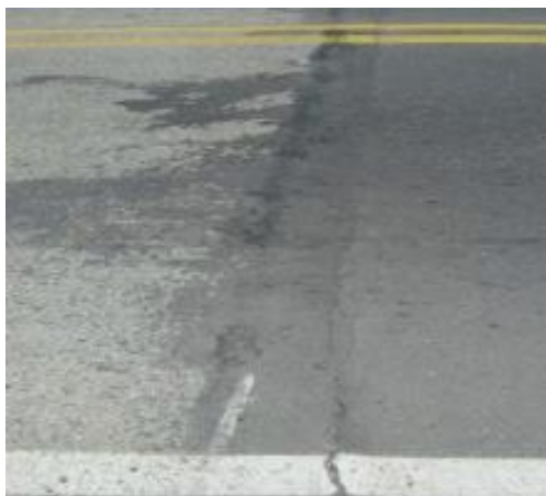
Figura N°13: Grieta transversal
