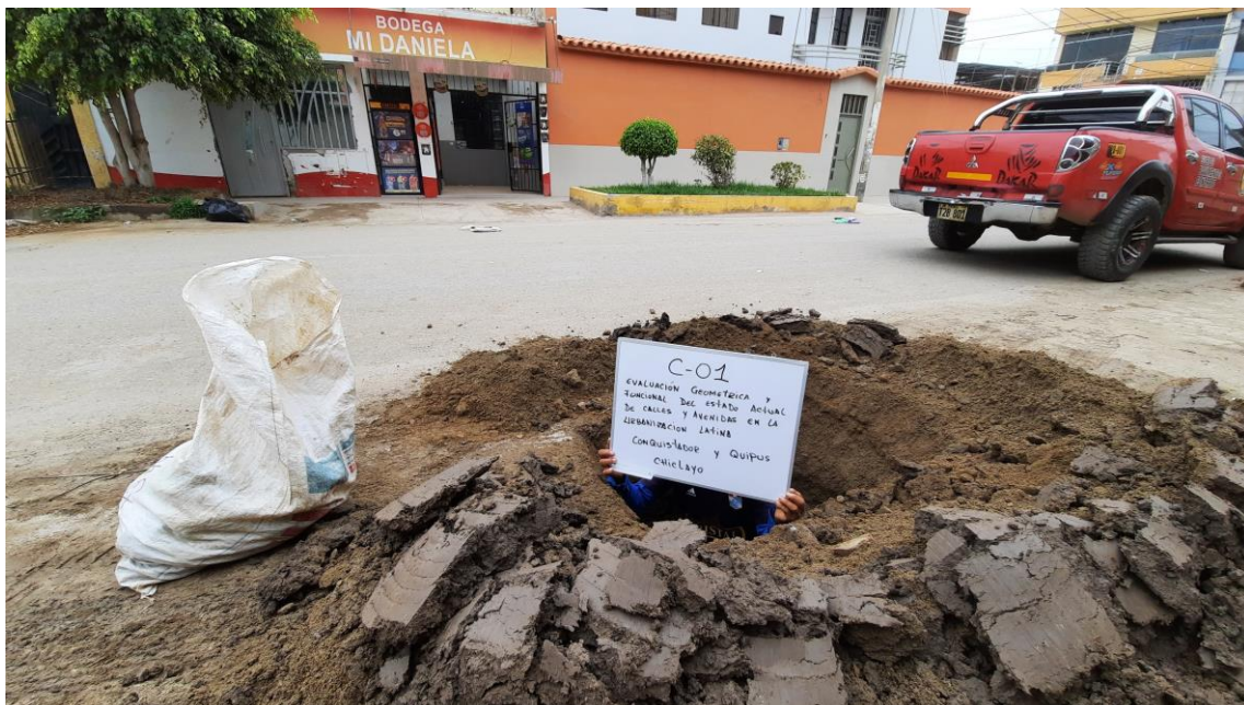
Calicata n° 01 en Urbanización Latina
