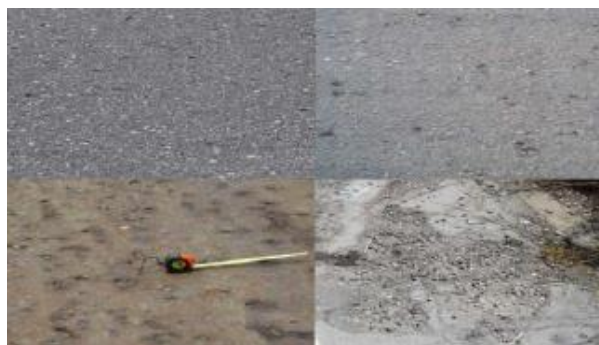
Figura N°22: Disgregación / desprendimiento
