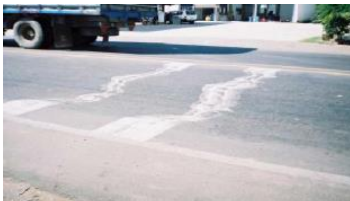
Figura N°18: Ahuellamiento
