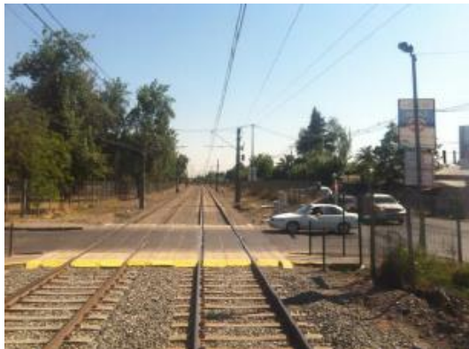
Figura N°17: Cruce de ferrocarril
