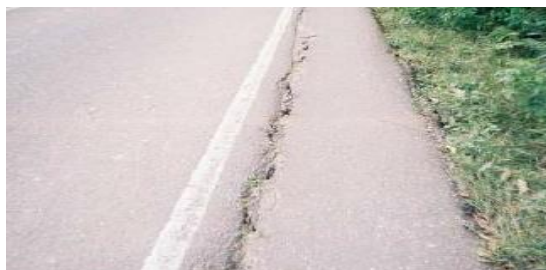
Figura N°11: Desnivel carril/berma
