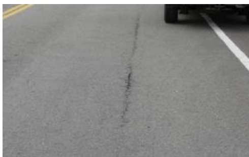
Figura N°12: Grieta longitudinal
