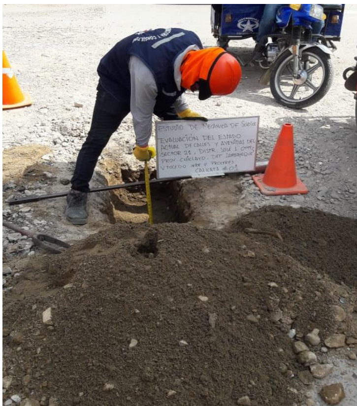
Calicata n° 01 en Urbanización Latina
