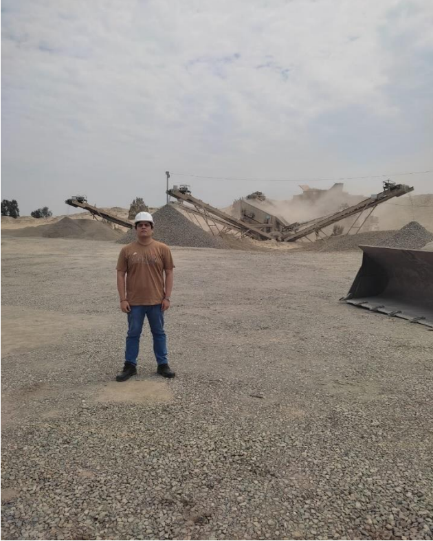
Ilustración 7: Trituración RCD Fuente 9: E. Propia
