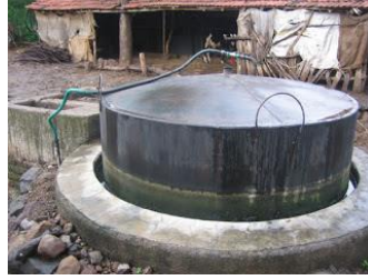
Fig. 8. Biodigestor de flujo discontinuo [25].
