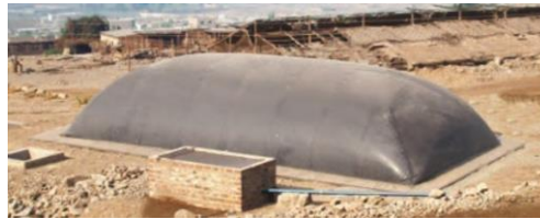
Fig. 9. Biodigestor tipo laguna cubierta [26].
