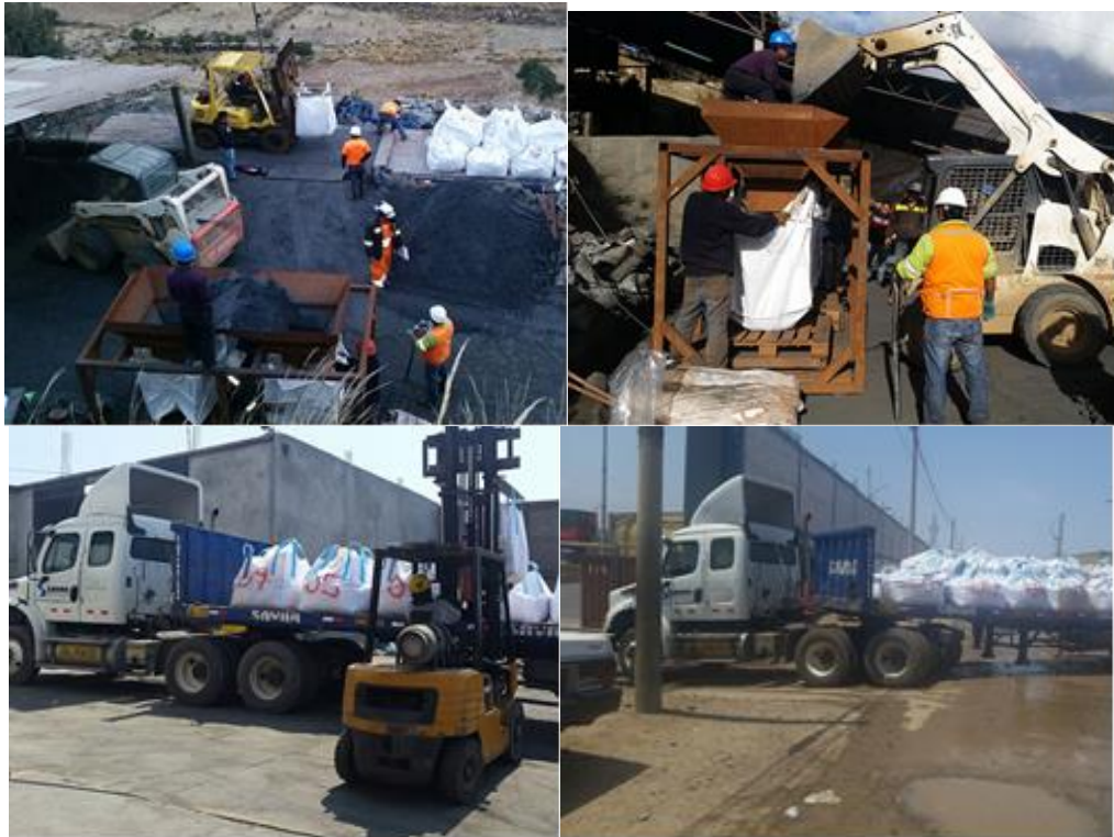
Figura 9. Proceso de carga de concentrados de Pb, Ag, Cu en FIBC's para ser transportados al Puerto del Callao. Fuente: S.M.R.Ltda SANTA ANA de Pacota I 2016
