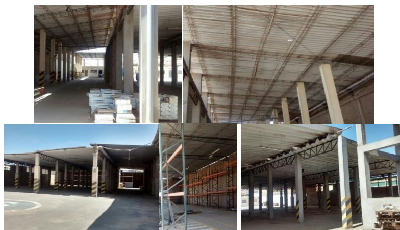
Figura 40. Imágenes del Parque Industrial Mz C It 23
