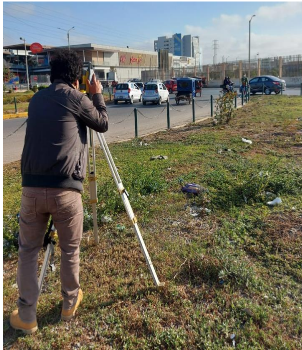
Imagen N°29: Levantamiento topográfico en rotonda
