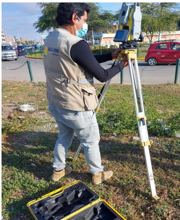
Imagen N°30: Colocación de estación total
