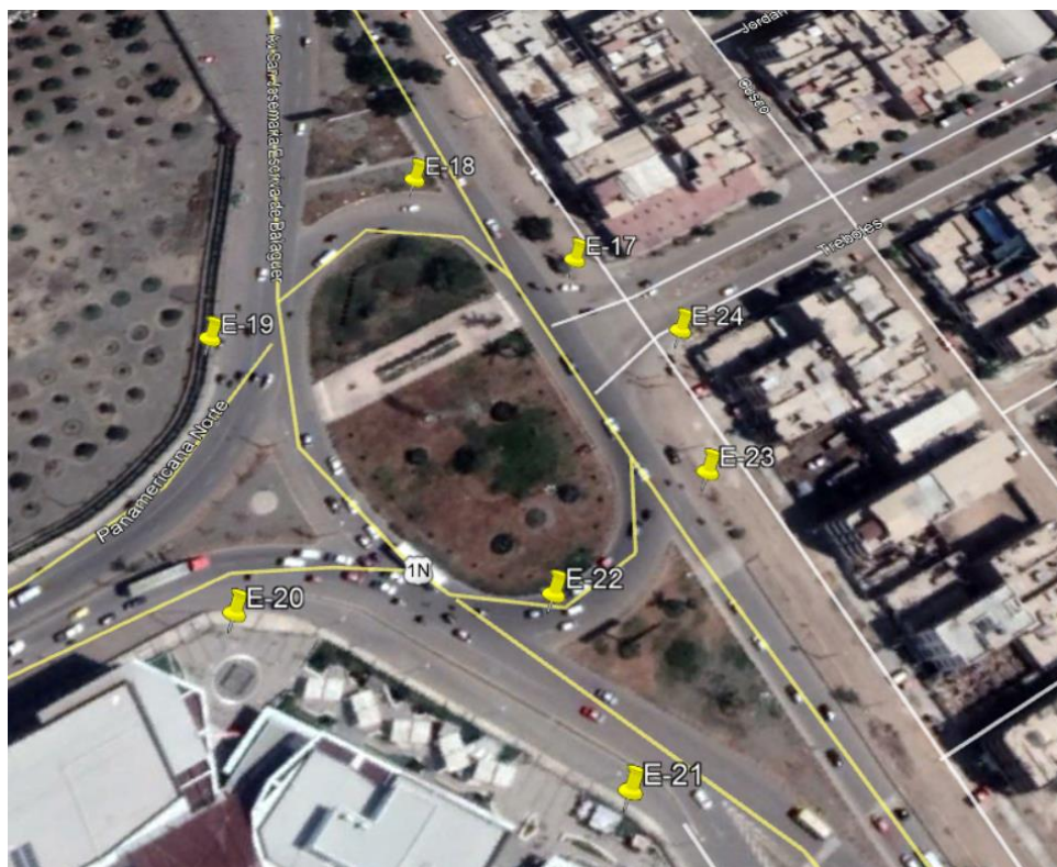
Imagen N°14: Intersección de Av. Prolongación Augusto B. Leguía y Av. José María Escrivá
