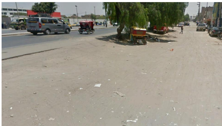
Imagen N°56: Berma sin delimitar entre vía principal y auxiliar
