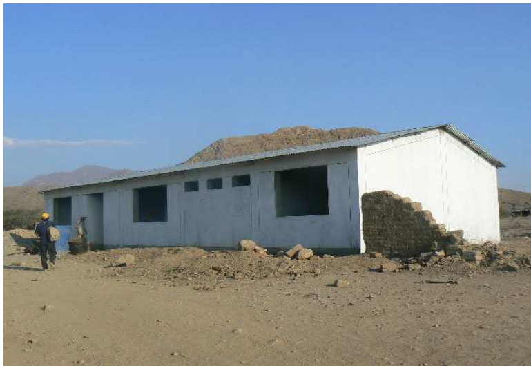
Figura 5. Posta Médica del centro poblado Pacherrez, recientemente concluida su construcción. Chiclayo – Perú, 2009.
