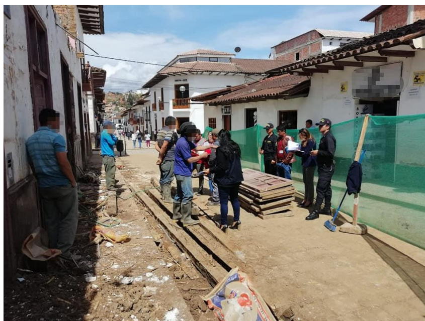
IMAGEN 20. Destrucción de Casona en centro histórico de la ciudad
