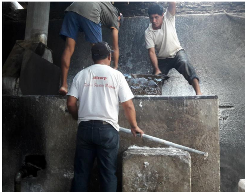
Figura N° 7 Operarios sacando uno de los recipientes del horno
