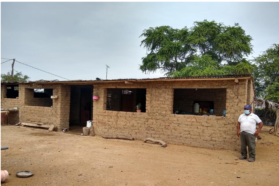
Imagen 36 Casa rural 03 de adobe en Popán - Vista frontal
