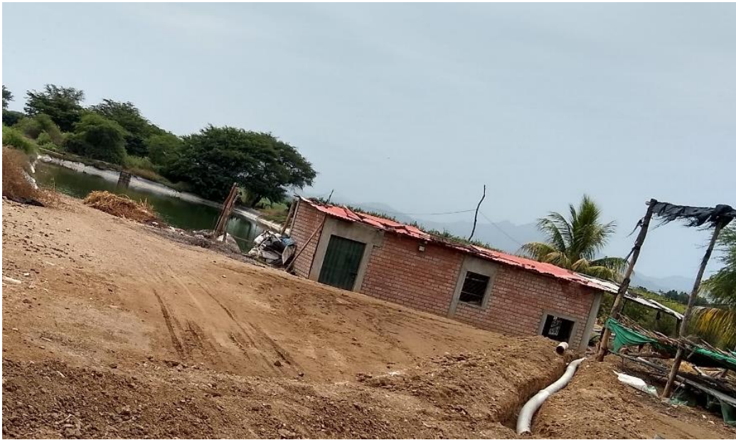
Imagen 37 Casa rural 04 de ladrillo en Popán
