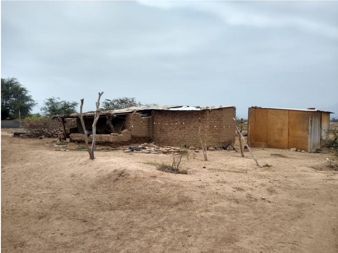
Imagen 39: Casa rural 05 de adobe en Popán - Vista frontal
