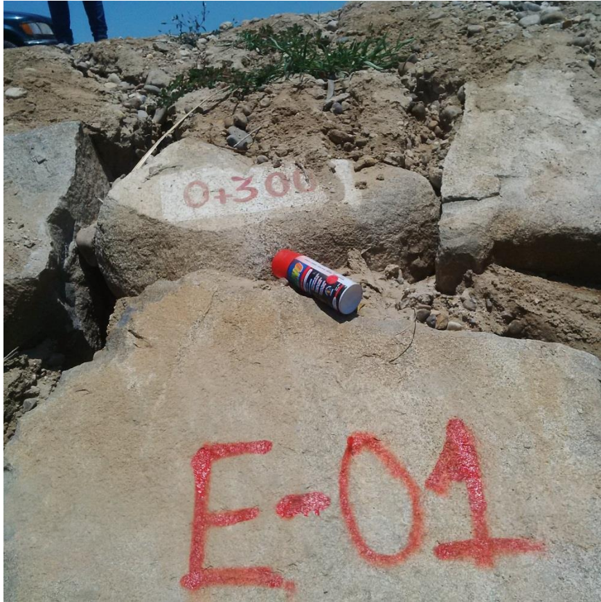
Figura 32: Estación 1 (E-01) a la altura del Kilómetro 0+300 del eje del Puente.
