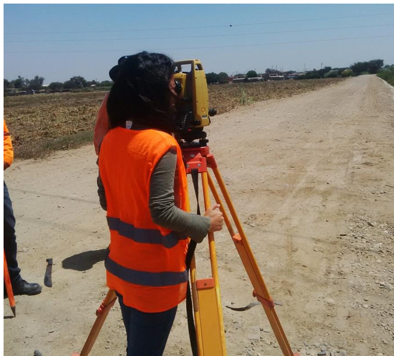
Figura 33: Vista de la Estación E-01 ubicado aguas abajo del Río Reque.
