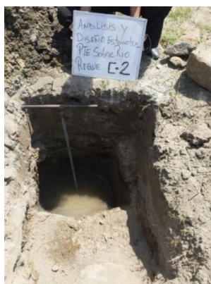
Figura 56: Calicata N° 2 a orillas del cauce del río.
