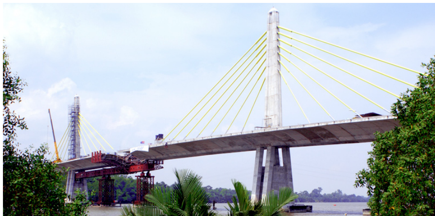
Puente Sungai Muar (Malasia)
