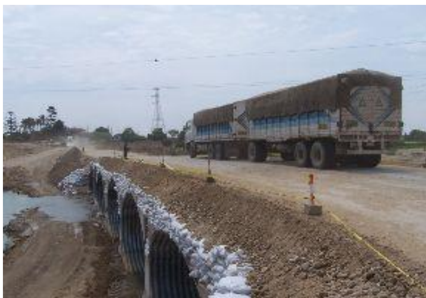
Figura 124: Badén reconstruido después del colapso producido en el año 2008.
