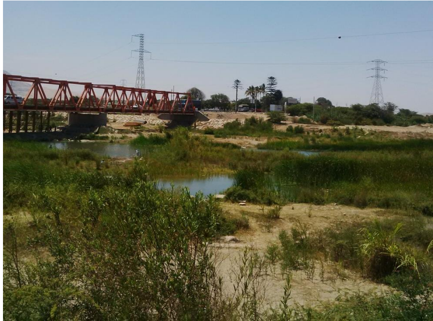
Figura 30: Vista aguas abajo del Río Reque.
