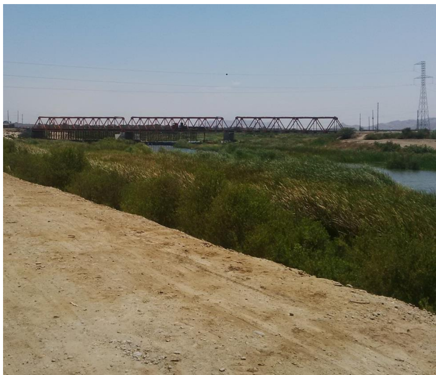
Figura 29: Vista aguas abajo del Río Reque.
