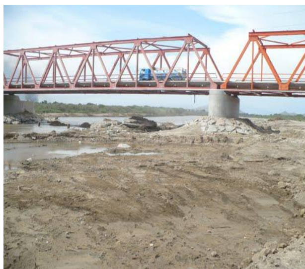
Figura 125: Vista Lateral del Puente Reque Ampliado y Reforzado.
