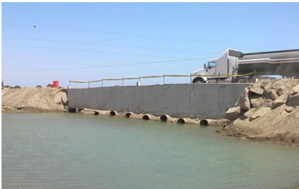
Figura 122: Badén construido de forma provisional.
