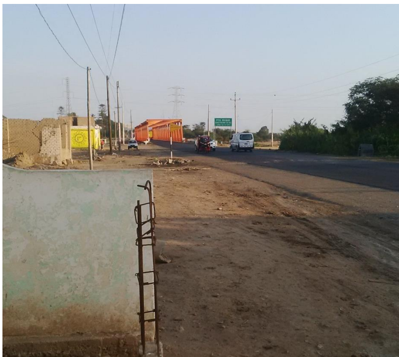
Figura 47: Vista al Puente Reque desde el punto de control.
