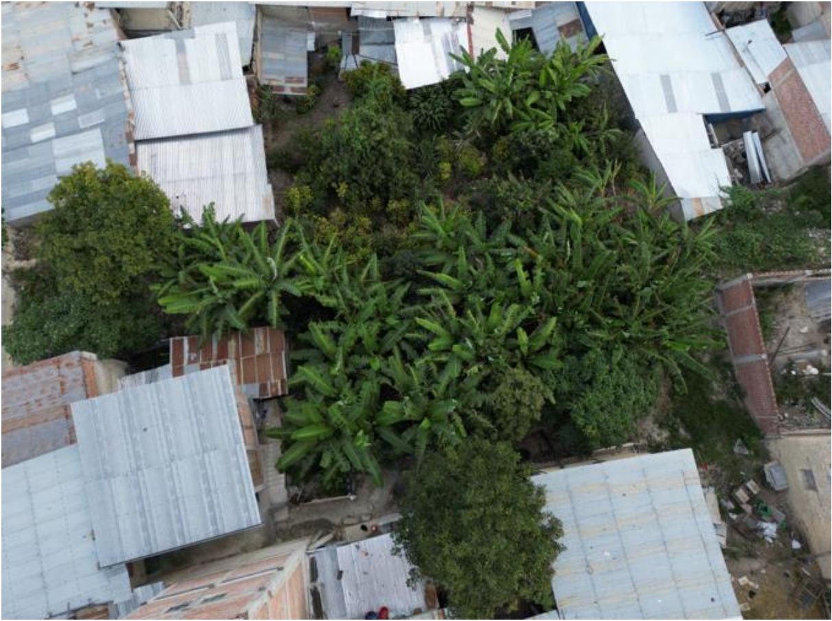
Imagen N°08: Parte central de zona crítica de deslizamiento
