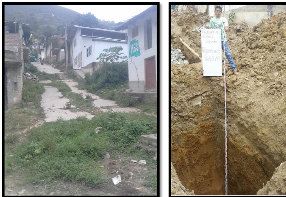
a) Inclinación del talud.
