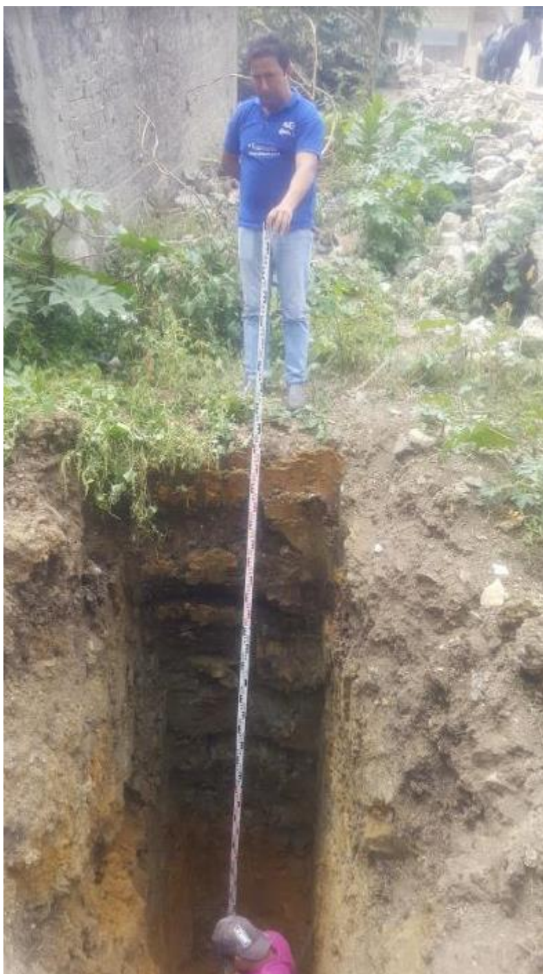
Fotografía 06: Medición de calicata N°03
