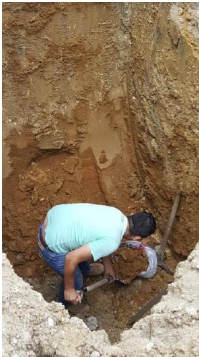
Fotografía 02: Obtención de muestras alteradas de calicata N°01
