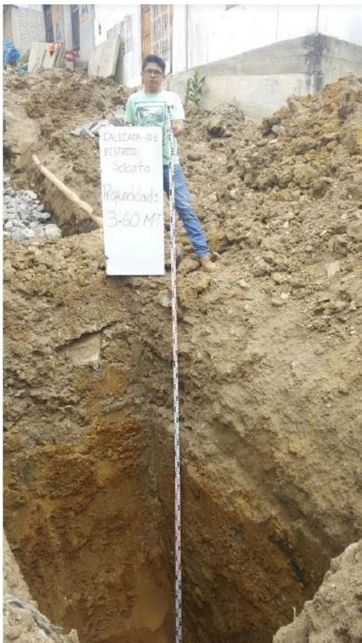
Fotografía 01: Excavación de calicata N°01
