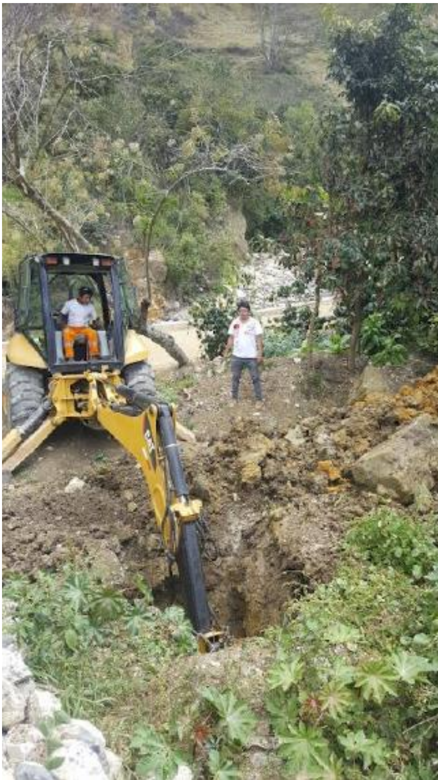
Fotografía 05: Excavación de calicata N°03
