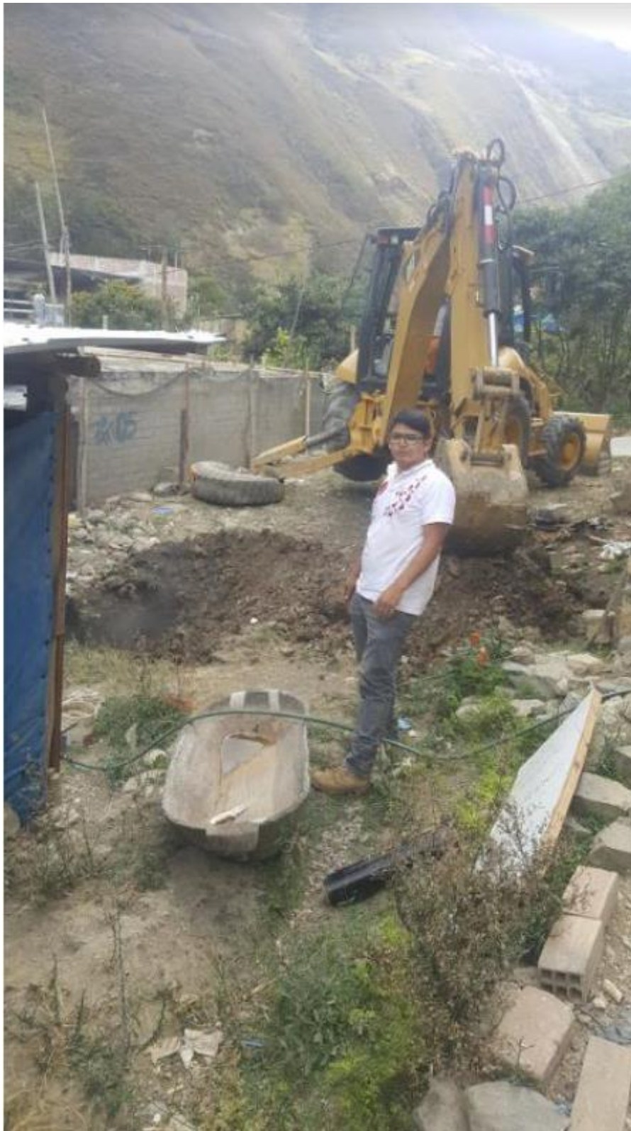
Fotografía 07: Excavación de calicata N°04
