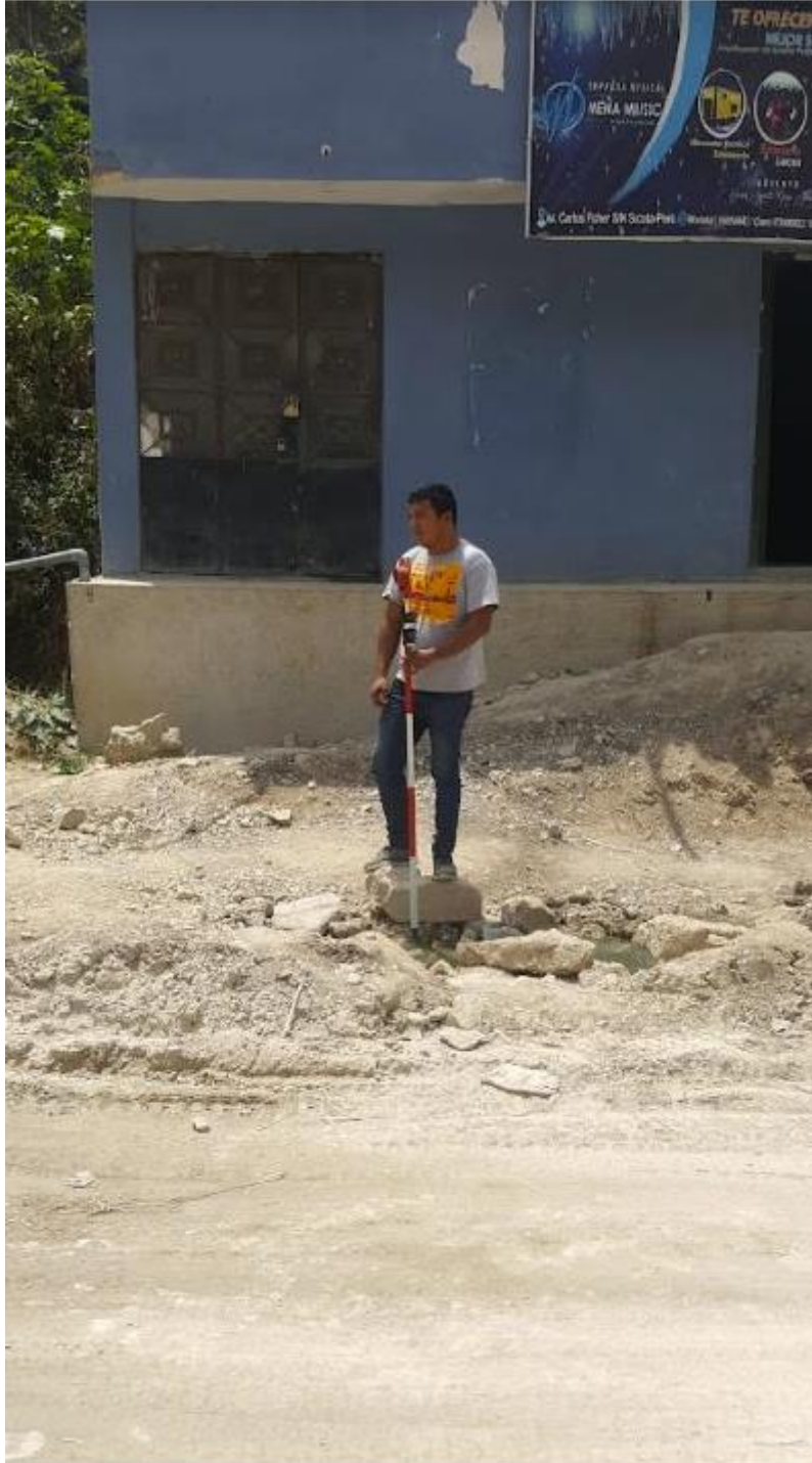
Imagen N°04: Levantamiento con estación / Calle Carlos Fisher
