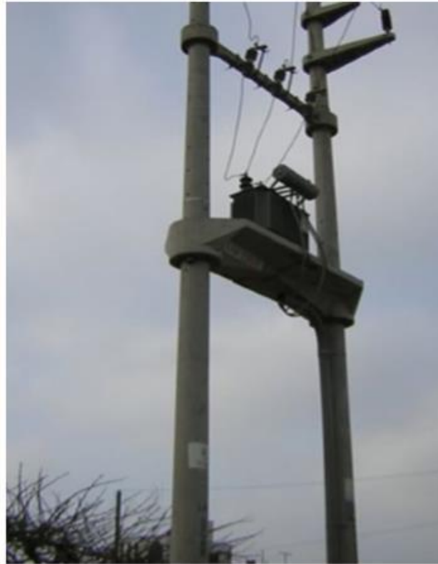
Figura 10. Subestación aérea [24].
