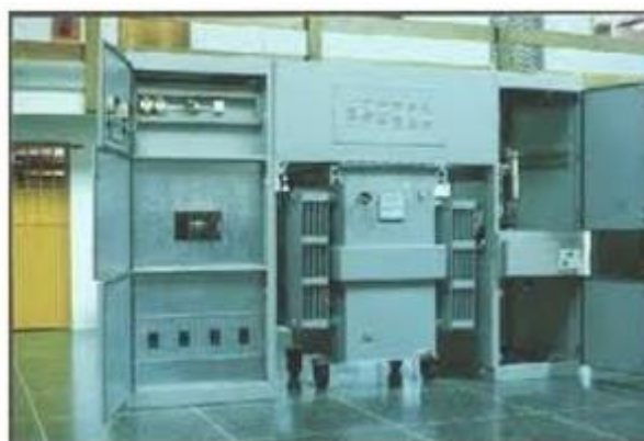
Figura 8. Subestación interior [24].
