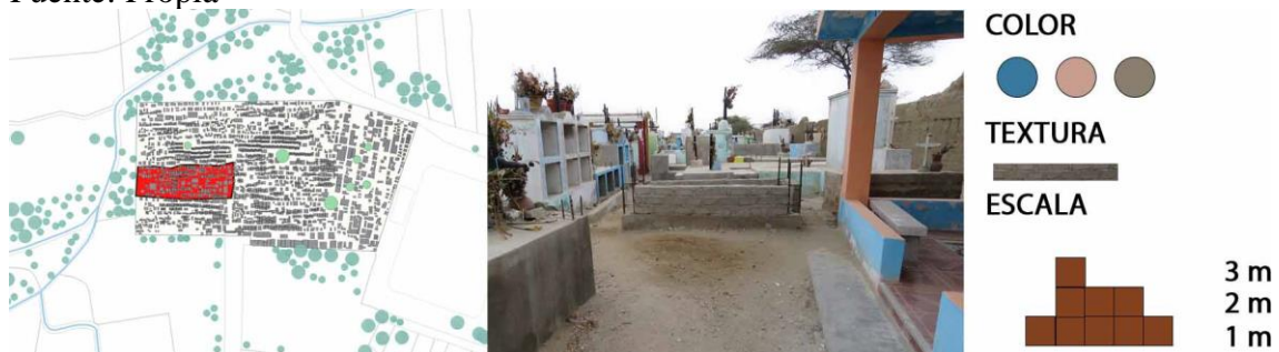
Figura 15: Zona B del cementerio actual de Mórrope Fuente: Propia
