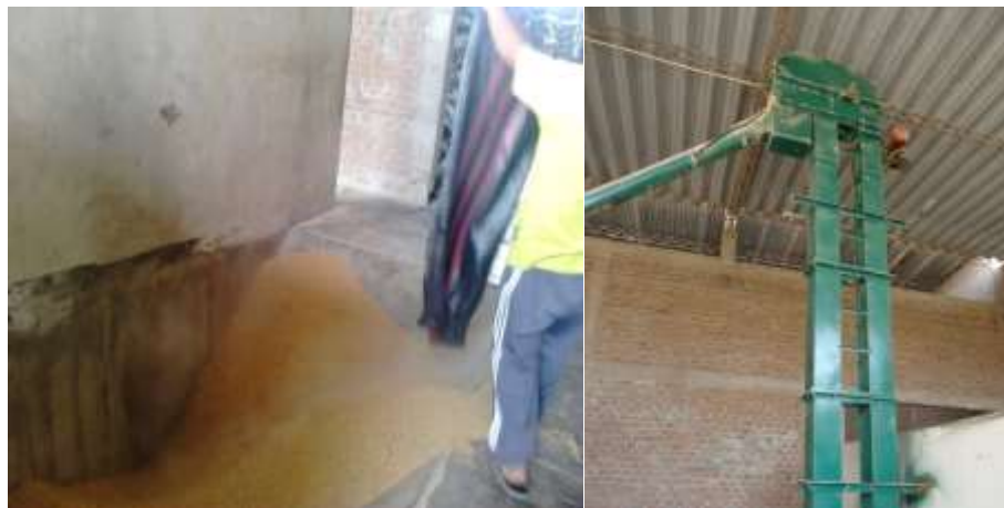
Figura 1: Maquinaria del Área de Recepción
