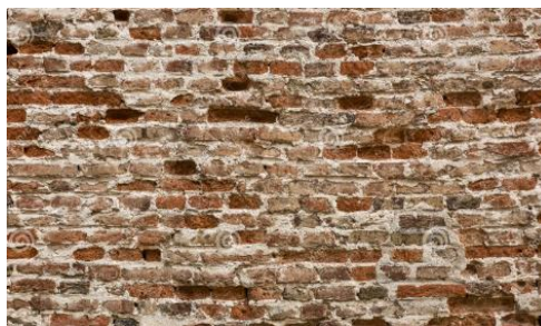
Figura 3 Muro de ladrillo artesanal [1]
