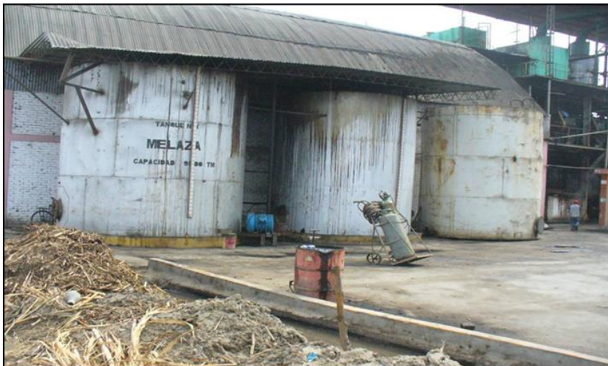
Figura 11: Tanques de melaza, al lado de la bodega de azúcar.
