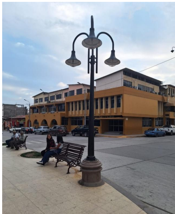
Figura 6. Luminaria actual de vapor de sodio
