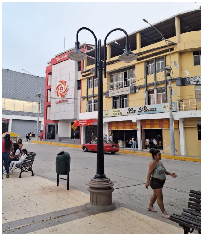
Figura 7. Luminaria de vapor de sodio
