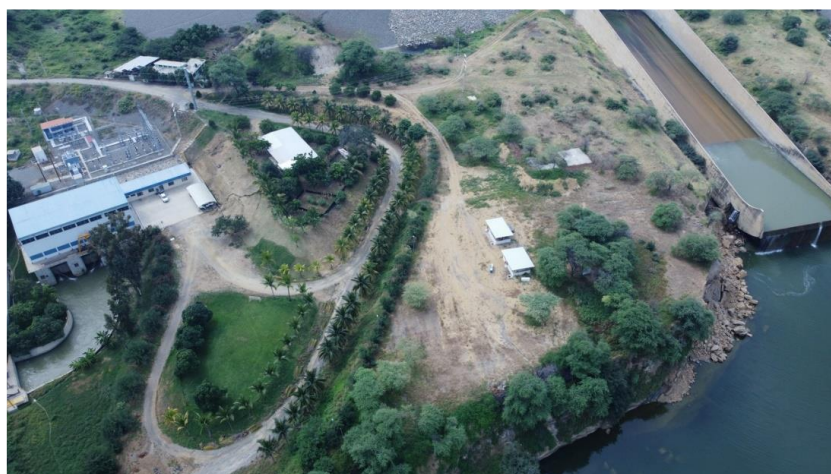
Figura 8. Vista aérea de Pochos I
